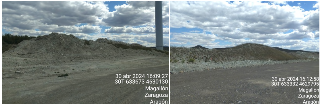
Acopios de tierras minerales y tierra vegetal ubicados en plataformas de aerogeneradores AGB2 (arriba) y AGB1 (Abajo).
