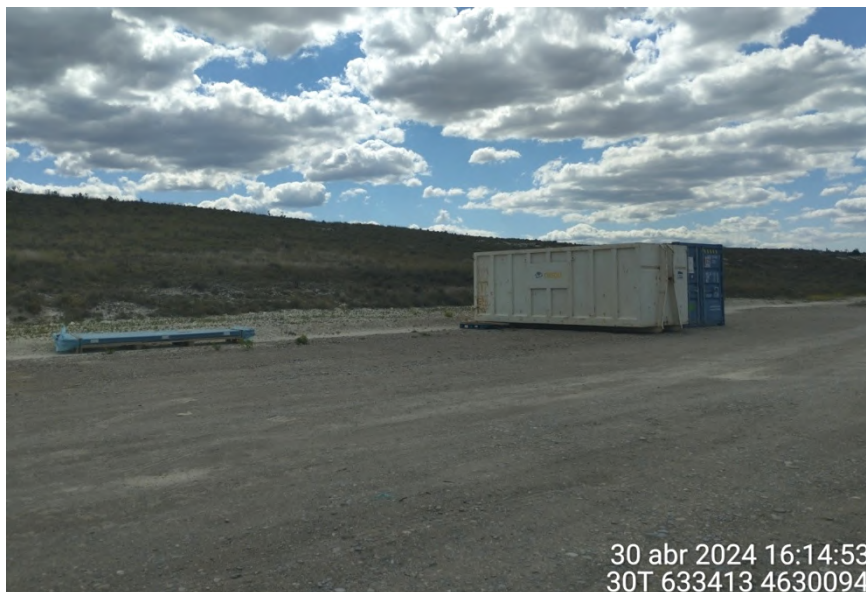
Estado del Site Camp el 30 abril de 2024, tras haberse retirado las casetas de obra dejando únicamente algunos materiales y los dos contenedores del punto limpio del Site Camp.
