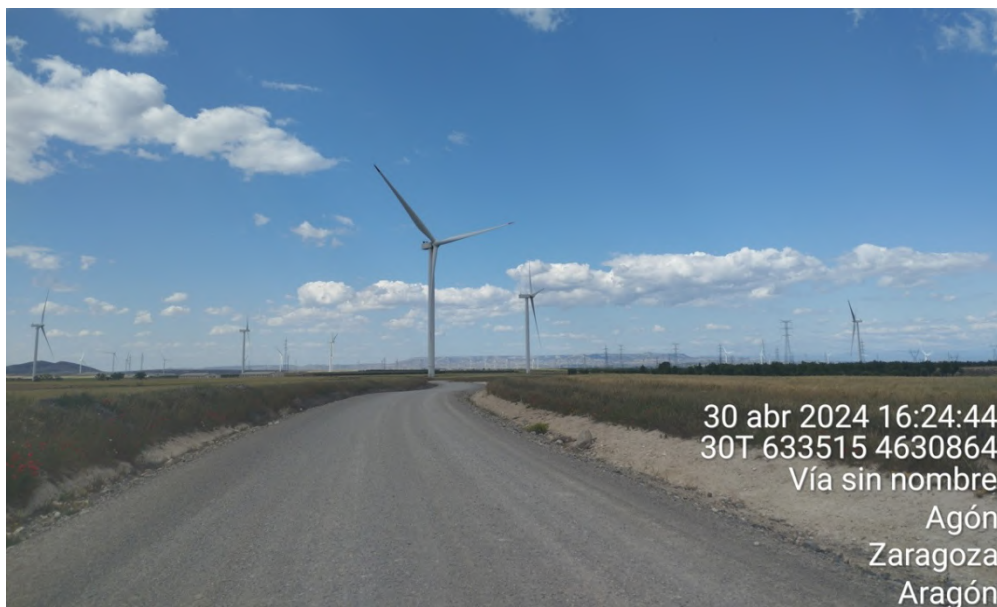
Viales de acceso a aerogenerador AGB-1 y 2.
