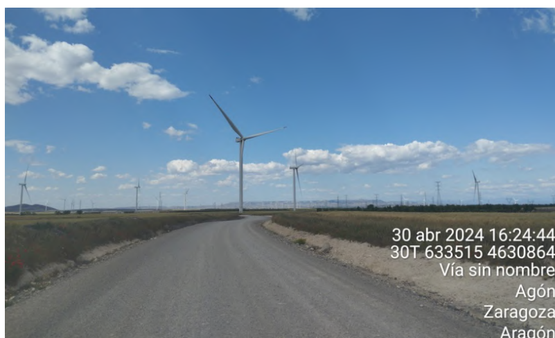
Fotografías del tramo de viales de acceso a los aerogeneradores de Agón 2 desde el PE en explotación “Tinajeros”, ya restaurados.
