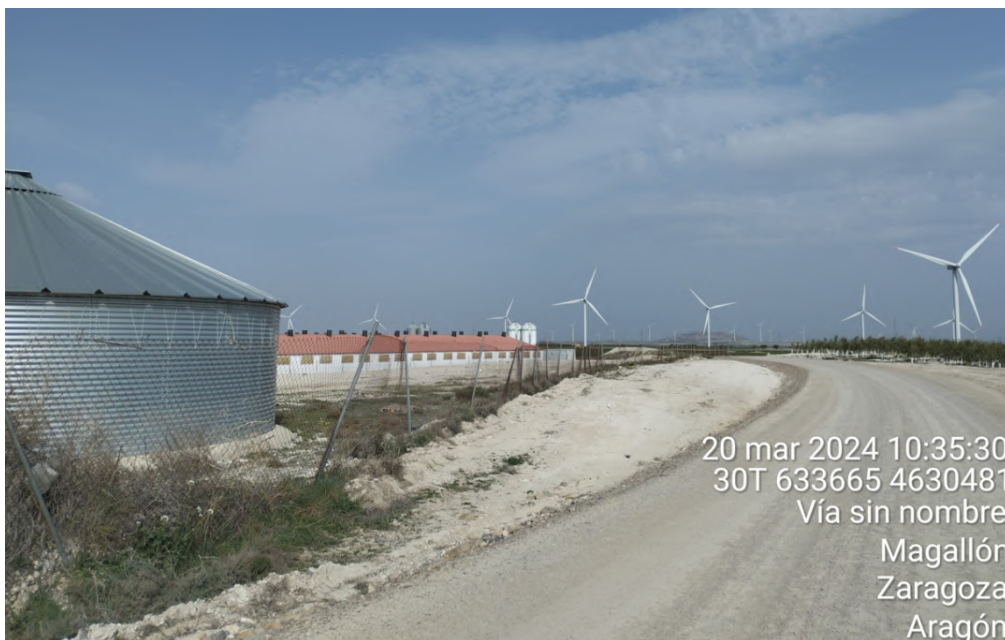
Fotografía del área N°8, ubicada entre el vial y una granja porcina.
