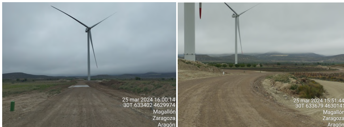
Viales de acceso a aerogenerador AGB-1 y 2.
