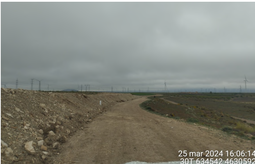
Fotografía del tramo norte del área N°1.
