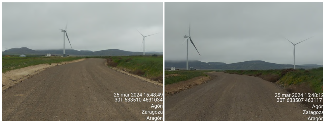
Fotografías del tramo de viales de acceso a los aerogeneradores de Agón 2 desde el PE en explotación “Tinajeros”, ya restaurados.
