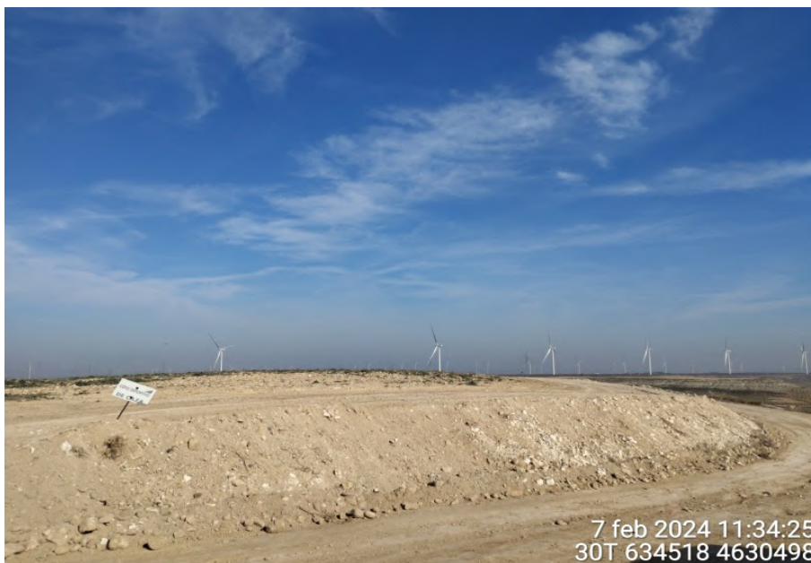
Fotografía correspondiente a punto 1 en su tramo sur. (tramo de zanja sur que transcurre sentido sur-norte por la parcela 9025, polígono 503 del municipio de Agón, así como por encontrarse de forma
