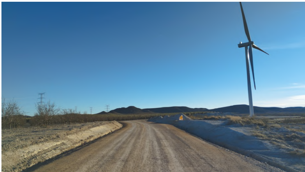
Viales de acceso a aerogenerador AGB-1 y 2.
