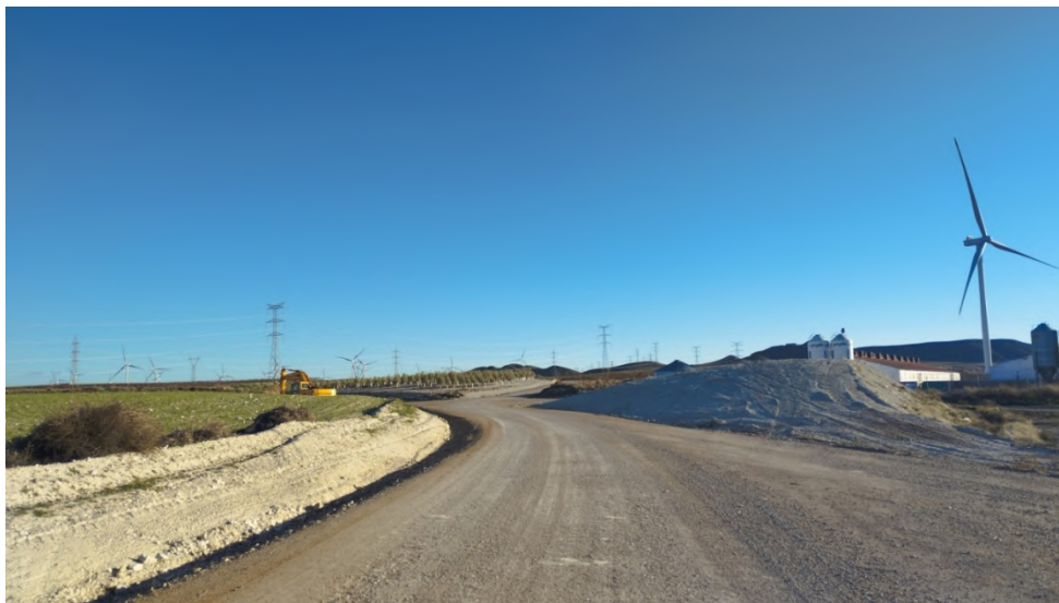
Fotografías del tramo de viales de acceso a los aerogeneradores de Agón 2 desde el PE en explotación “Tinajeros”, ya restaurados.
