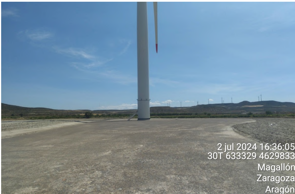
Estado de la plataforma de AGB-1 a julio de 2024.
