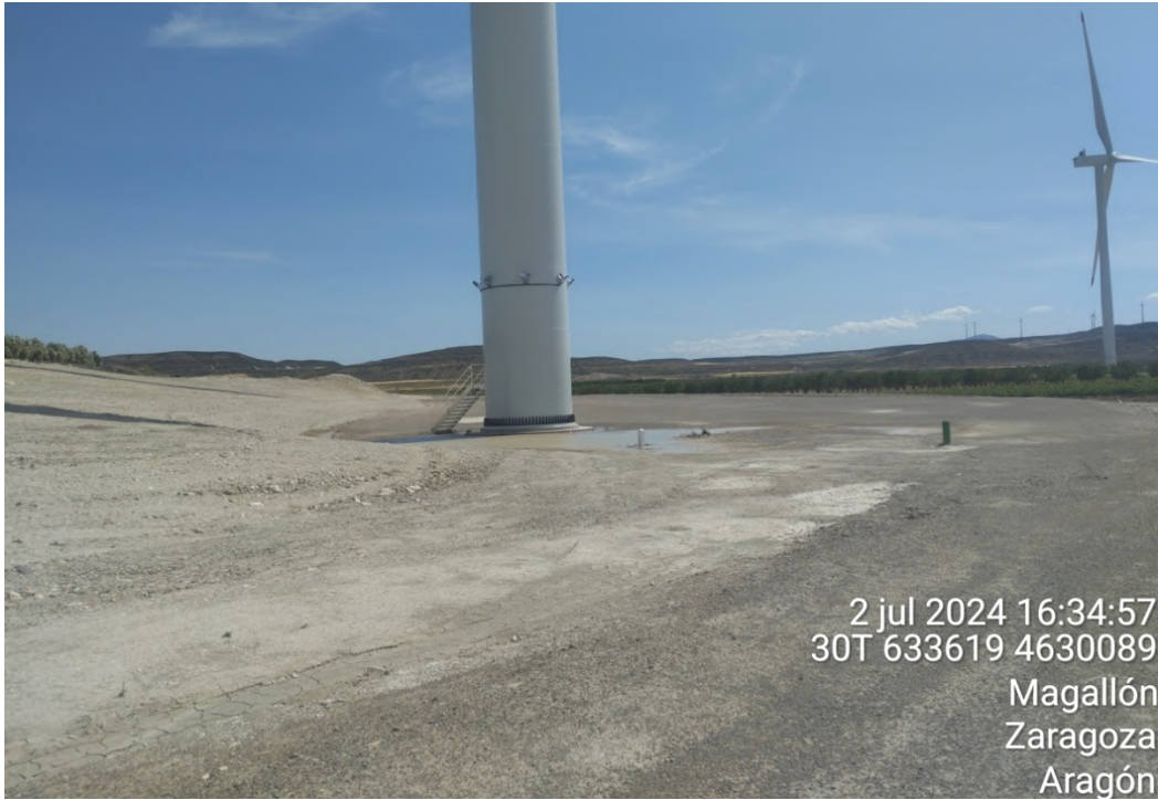
Estado de la plataforma y talud de AGB-2 a julio de 2024.
