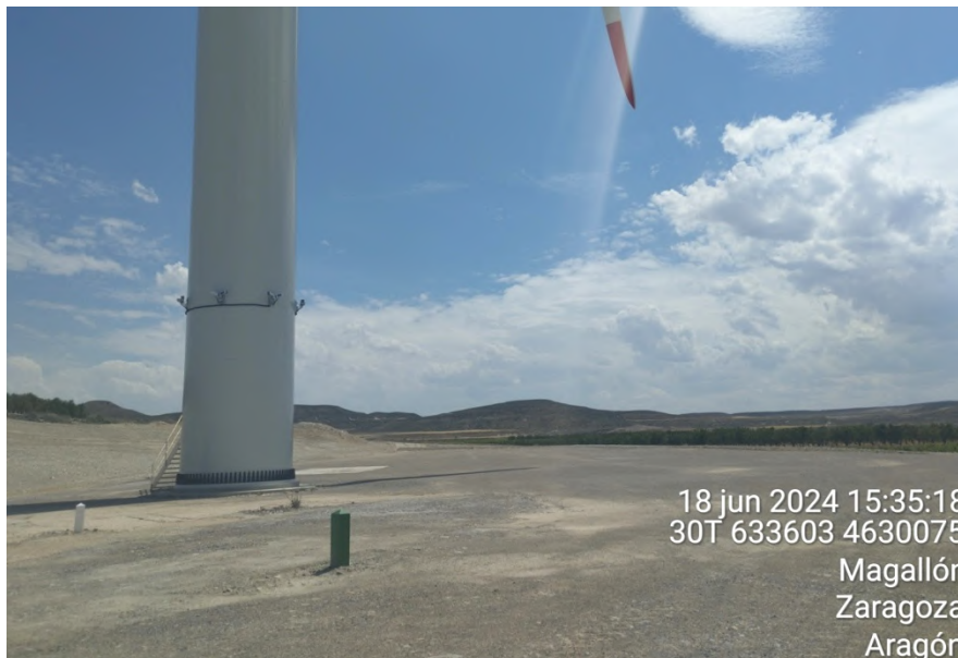
Plataforma y talud de AGB-2 finalmente restaurados a junio de 2024.
