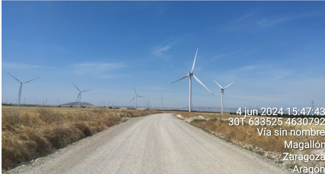
Fotografías del tramo de viales de acceso a los aerogeneradores de Agón 2 desde un PE aledaño ya construido y en explotación, ya restaurados.
