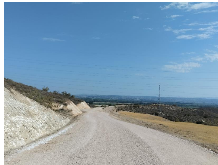
Situación en octubre de 2023 (fin de obras de la 1ª Fase)
