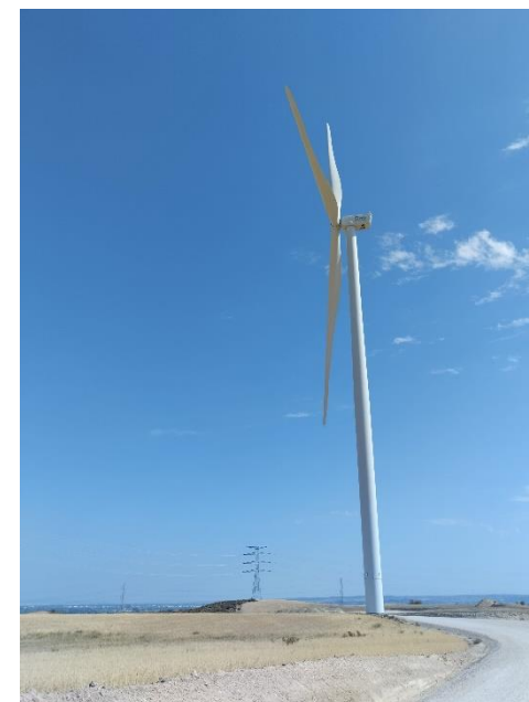
Situación en octubre de 2023 (fin de obras de la 1ª Fase)
