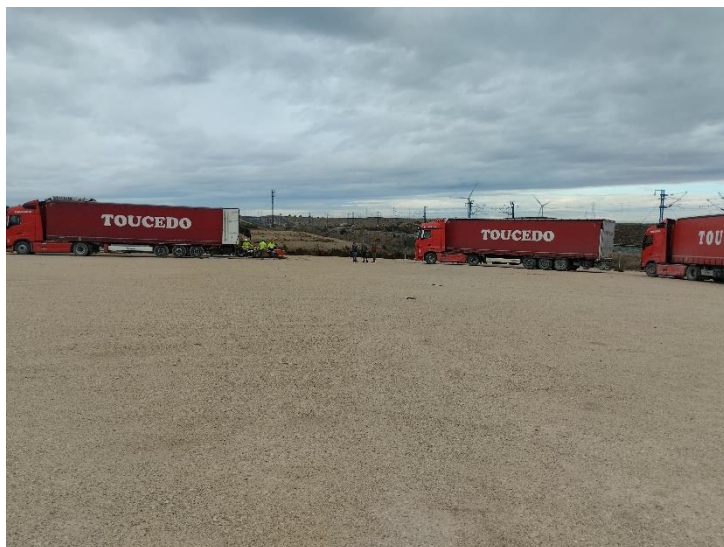
Inicio de obras, noviembre de 2022
