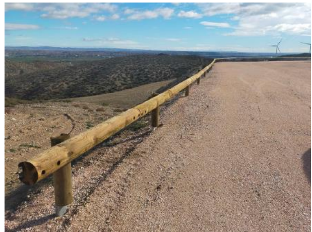
Biondas reforzadas y forradas en madera en las plataformas de los aerogeneradores ACS 03 y ACS 05 (17-10-23).
