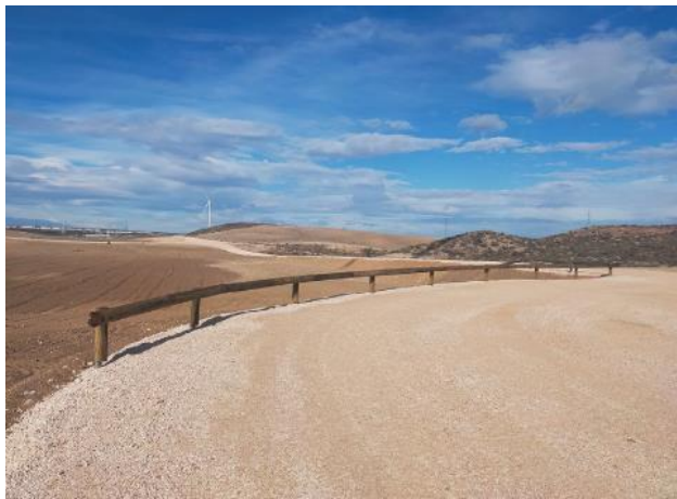
Biondas reforzadas y forradas en madera en las plataformas de los aerogeneradores ACS 03 y ACS 05 (17-10-23).
