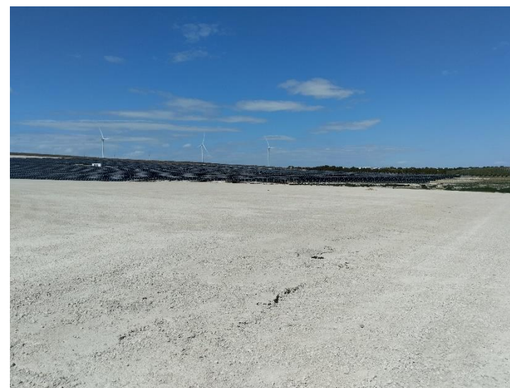
Situación en octubre de 2023 (fin de obras de la 1ª Fase)
