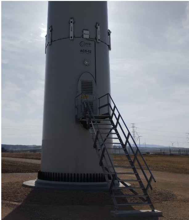
Dispositivos de detección, disuasión y/o parada, marca Bioseco, en los aerogeneradores CAS 02 y ACS 04 (17-10-23).
