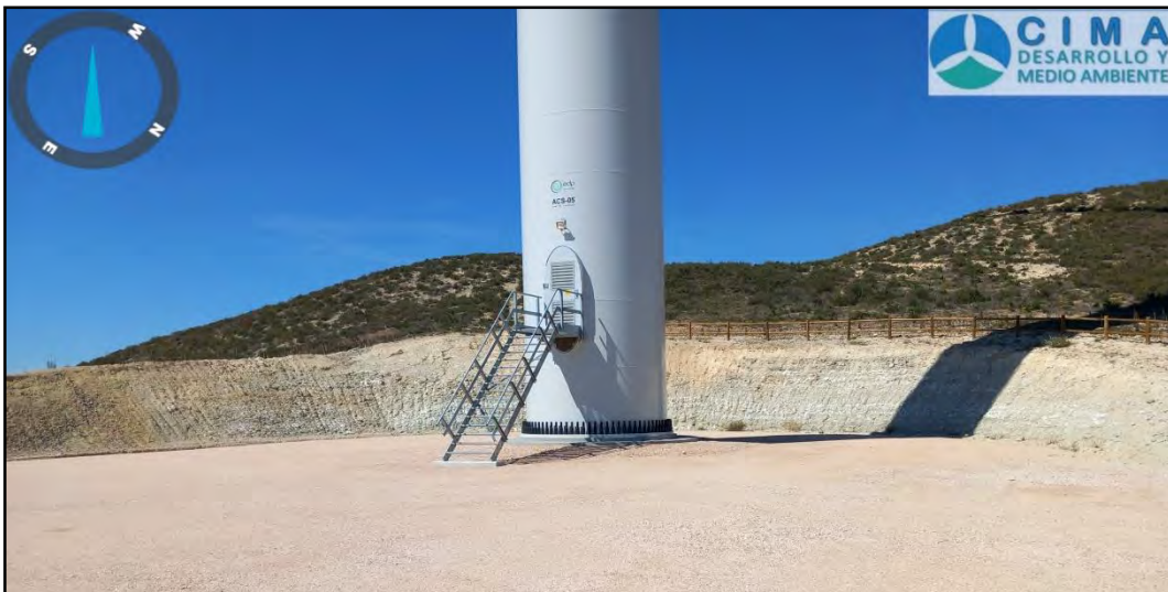
Fotografía 8. Desmante tras la turbina ACS05
