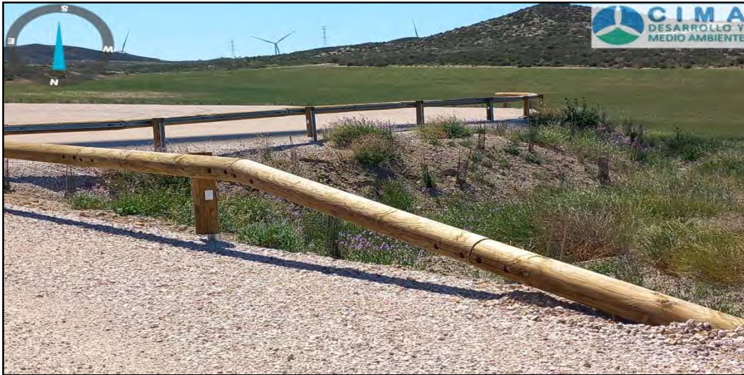
Fotografía 4. Revegetación en el entorno de la turbina ACS03
