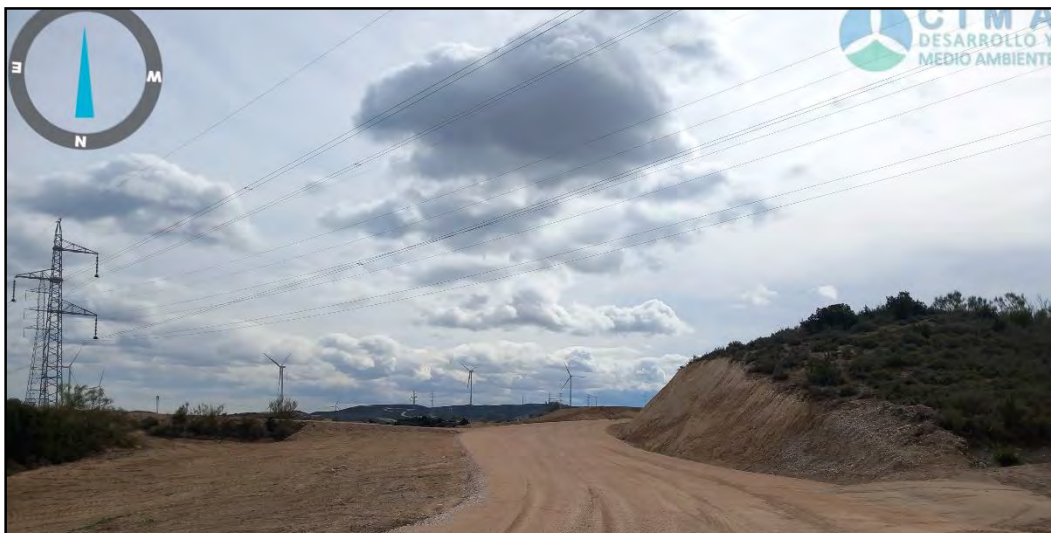
Fotografía 1. Estado del terreno sin signos de erosión
