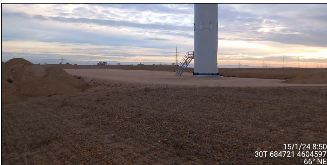
Fotografía 3. Vista general de la turbina ACS02.
