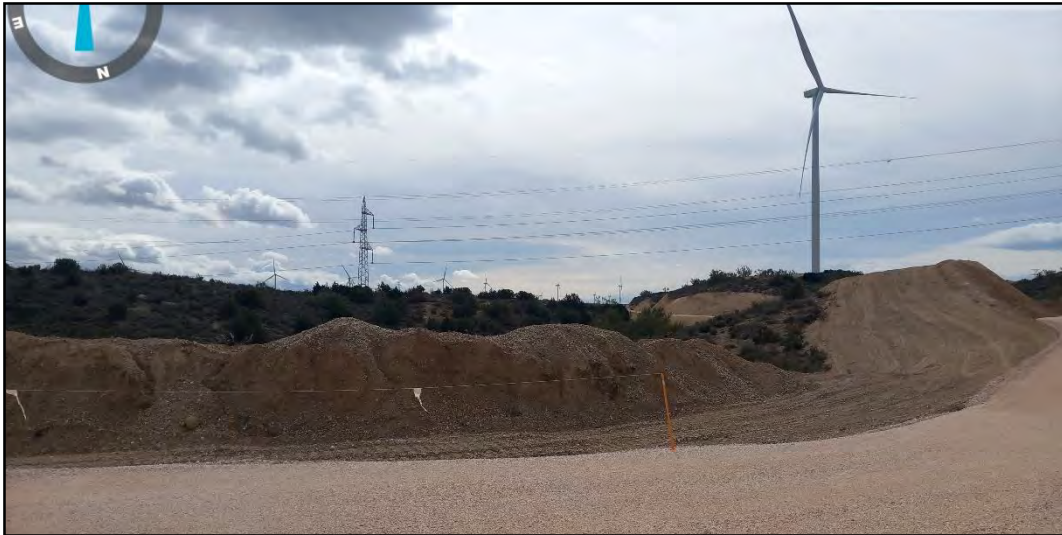
Fotografía 2. Terrenos preparados para la restauración paisajística en ACS01
