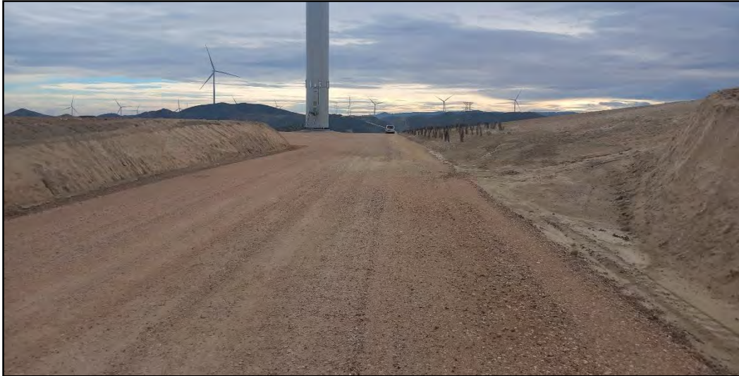
Fotografía 6. Acceso a la turbina ACS04 con desmontes laterales
