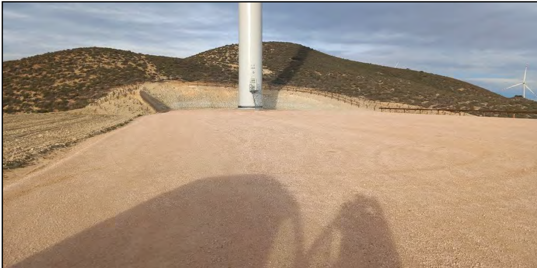
Fotografía 8. Desmonte tras la turbina ACS05
