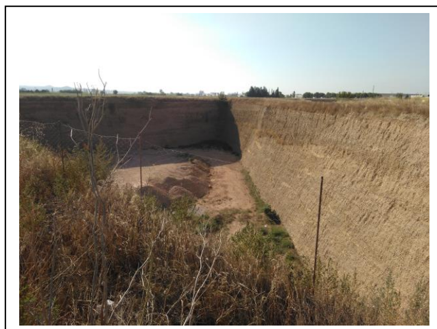
Imagen 3. Vista grado de erosión en talud del hueco minero
