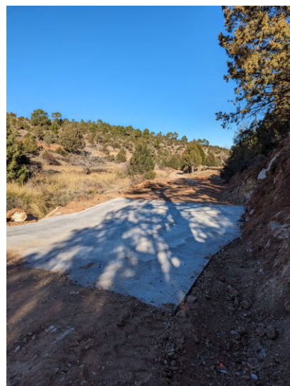
Badén de hormigón en la pista Los Callejones.
