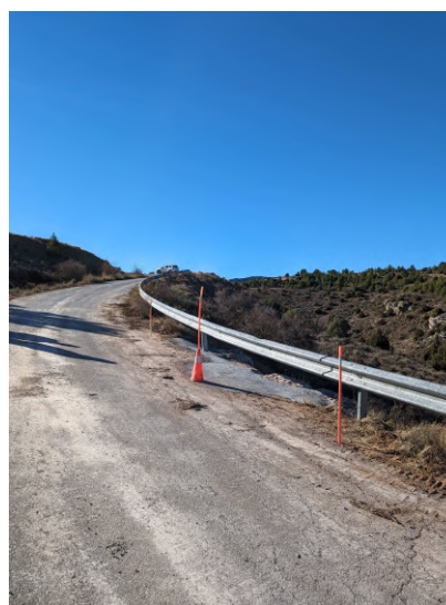
Pista asfaltada después de la actuación.
