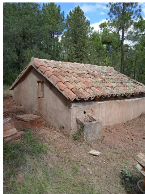
Estado final del caseto.
