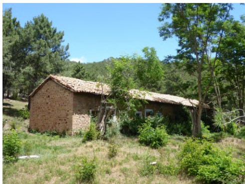
Vegetación alrededor del edificio.
