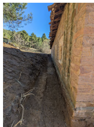
Parte trasera del edificio con la excavación y limpiada.
