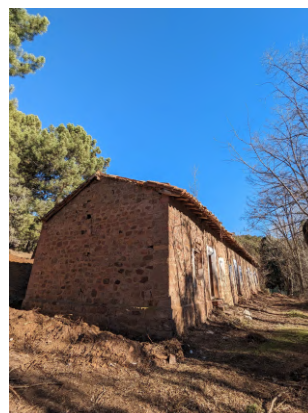
Sin vegetación alrededor del edificio.
