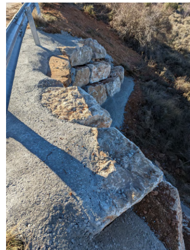
Salida de agua después de la actuación.
