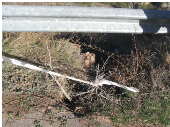
Pista asfaltada, junto al “quitamiedos”, antes de la actuación.
