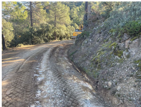
Retroexcavadora al fondo limpiando las cunetas.
