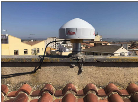
Estación ubicada en Binéfar
