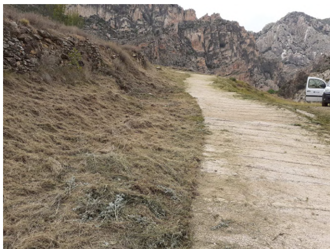
Desbroce en área recreativa de Montoro de Mezquita.
