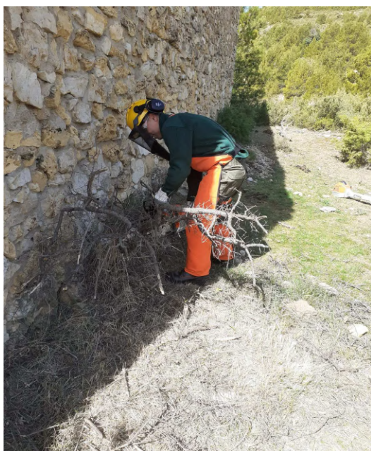
Retirada de ramas en el sendero el Higueral – Puente de Fonseca.
