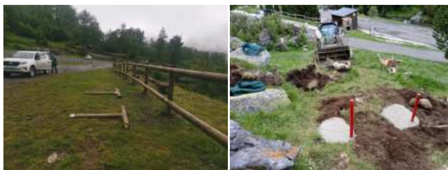
Colocación vallas en Estós y delimitación de parking e instalación de pérgola solar en el Vado.
