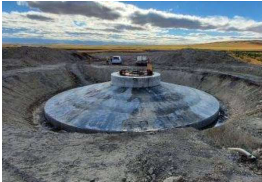
Imagen de cimentación tipo de Aerogenerador
