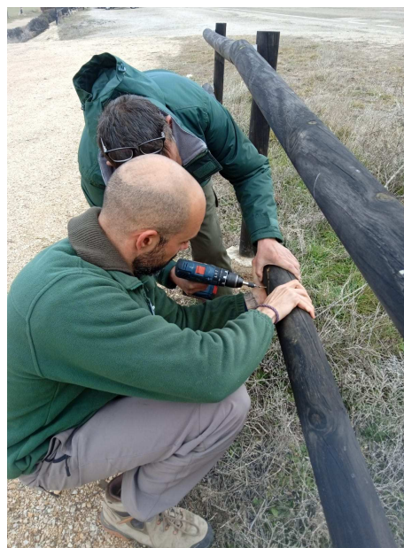
Mantenimiento del vallado del parking del C.I.
