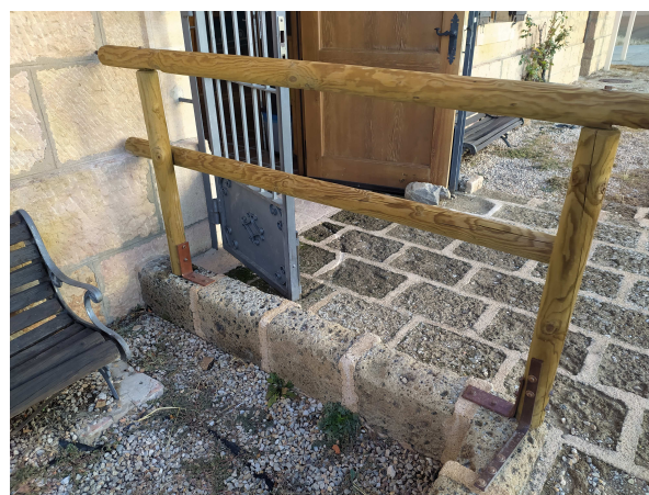
Adecuación de un vallado en la entrada al C.I.
