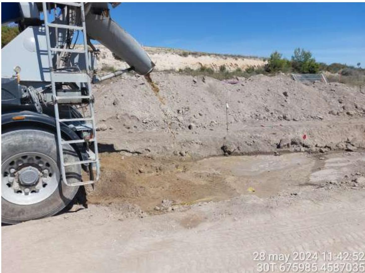
Imagen 1. NC grave. Lavado de canaleta de cuba de hormigón sobre suelo sin protección fuera de zona habilitada para ello.
