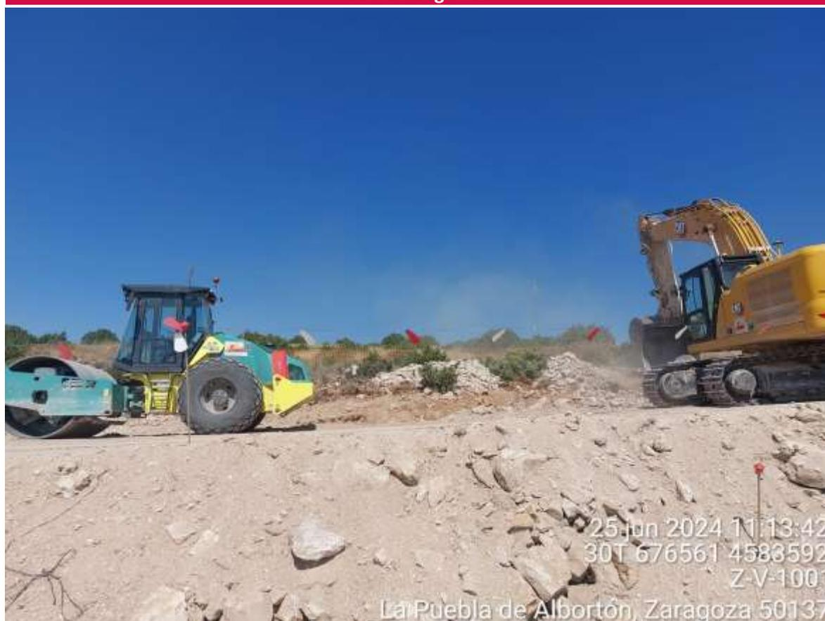
Imagen 1. Trabajos de tapado de zanja en LAT Canteras.
