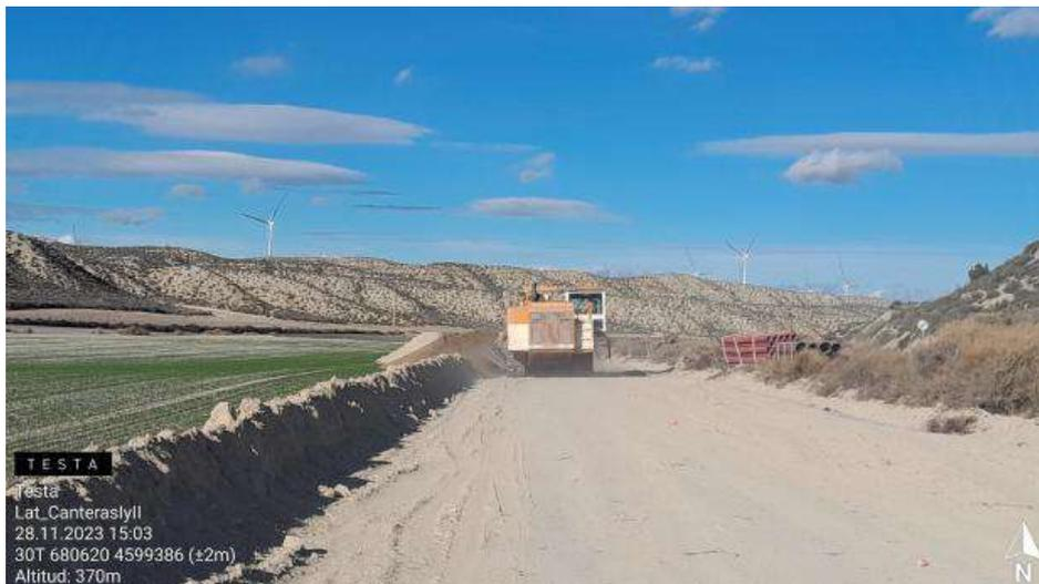
Zanjeadora mezclando tierra de excavación con tierra vegetal .
