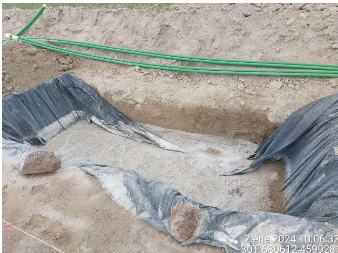
Imagen 1. No conformidad leve. Contaminación del suelo con hormigón debido a que el plástico no impermeabiliza el suelo.
