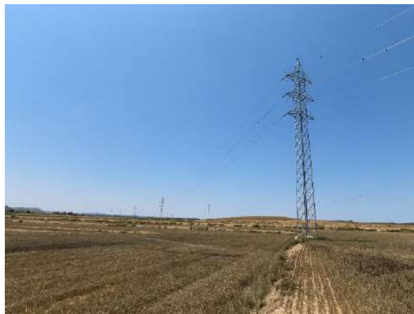
Figura 13: Vista del entorno del apoyo 14 de la LAAT
