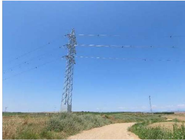
Figura 12: Vista del entorno del apoyo 15 de la LAAT.
