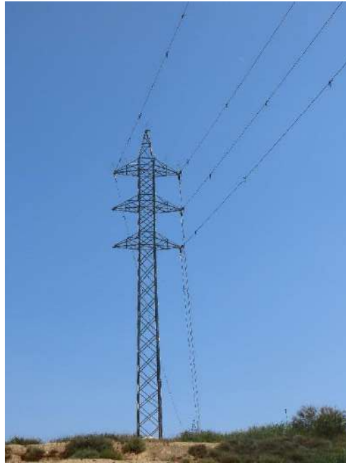
Figura 10: Vista del entorno del apoyo 8 de la LAAT
