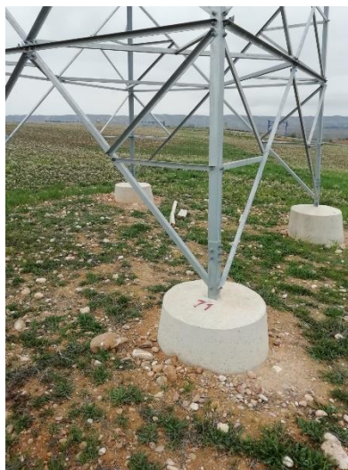
Fig.2. Estado general de apoyos y señalización.
