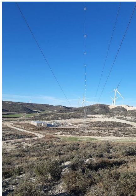
Fig.1. Estado general de balizas salva-pájaros y materiales aislantes.
