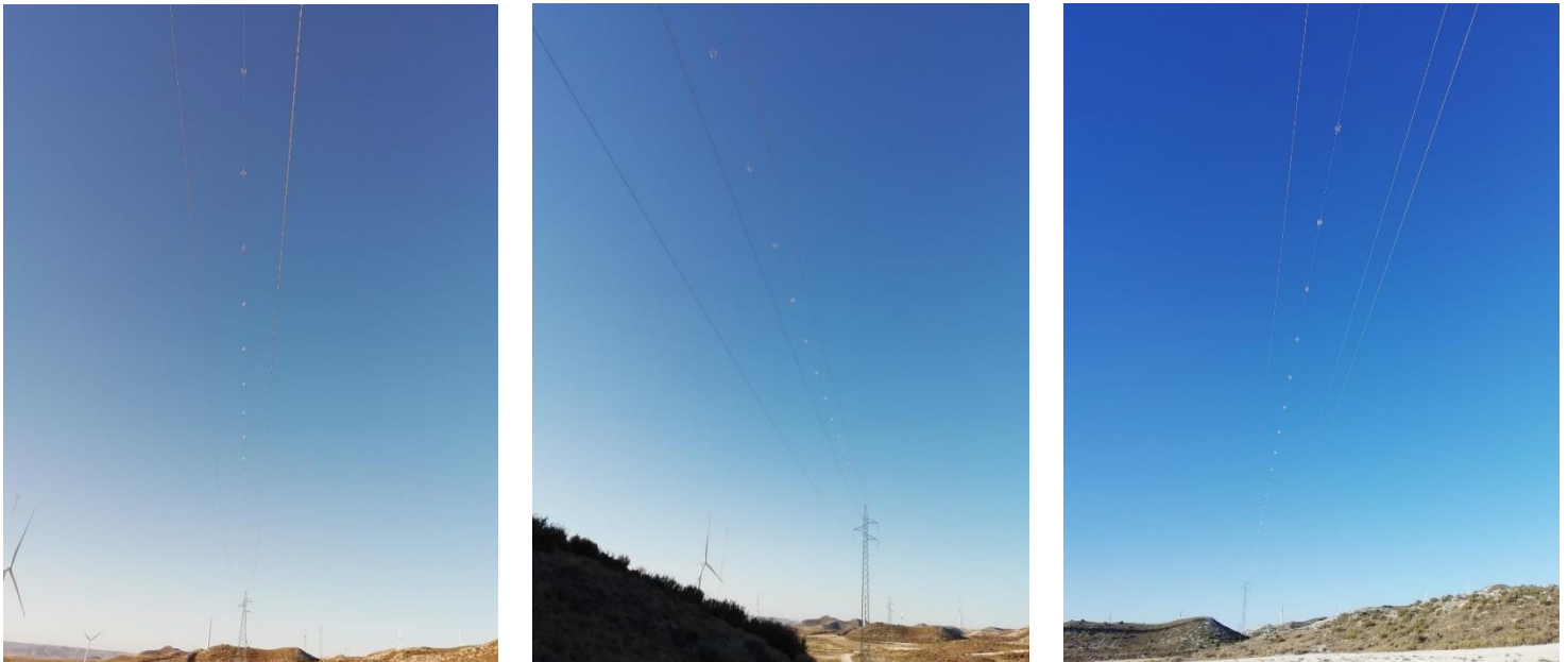
Fig.1. Estado general de balizas salva-pájaros y materiales aislantes.
