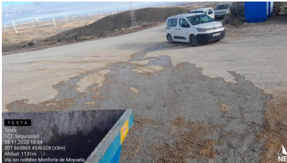
Derrame da lavado de cubas en SET Seguras.
