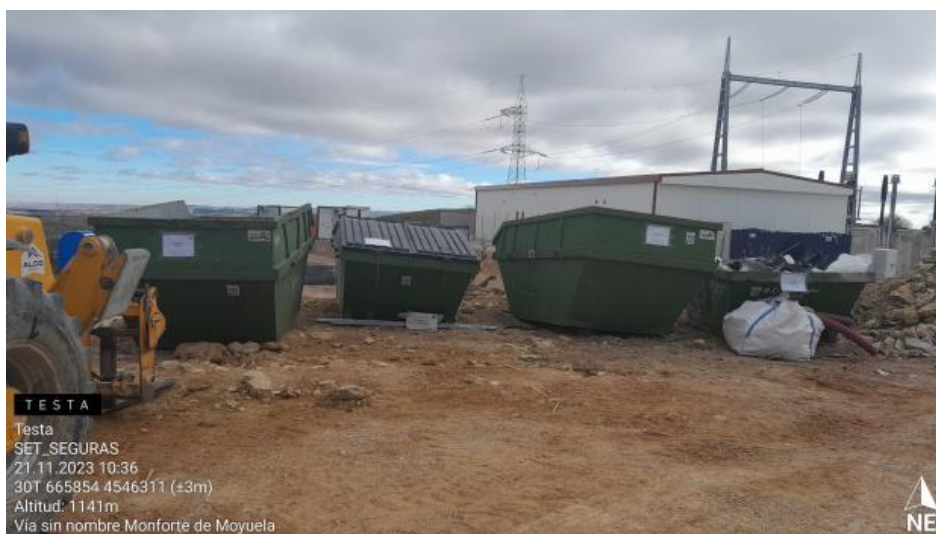
Punto limpio con contenedores gestionados en SET Seguras
