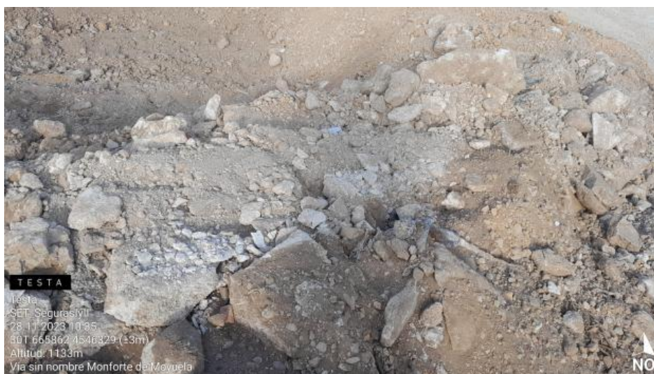
Restos de hormigón en desmantelamiento de balsa de lavado .
