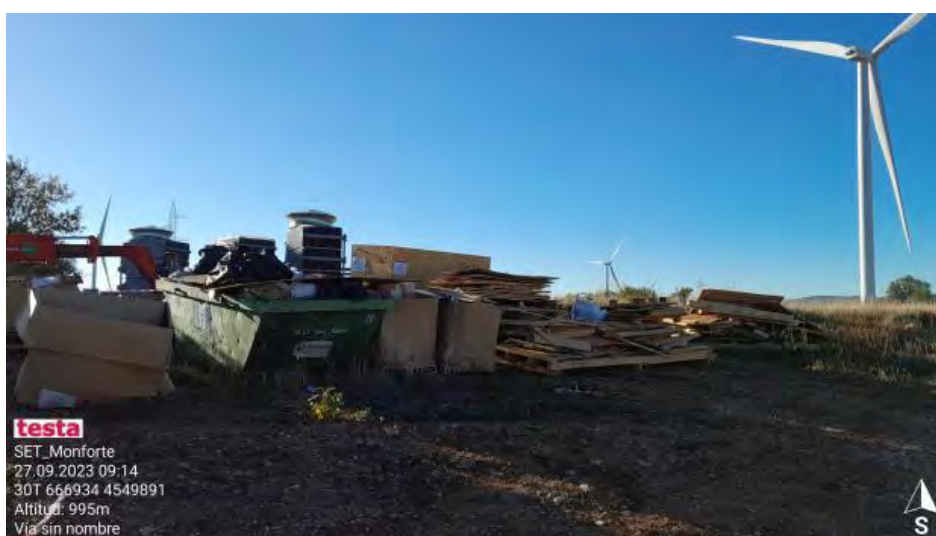
Contenedores de RNP llenos en SET Monforte.
