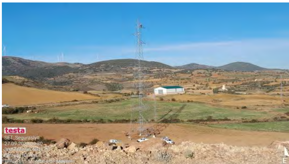
Montaje de apoyo.
