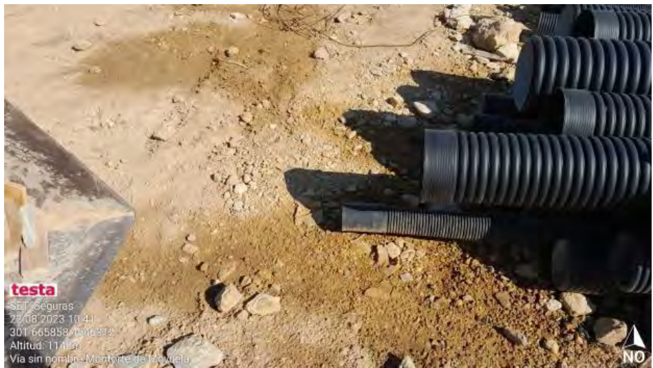
Derrame en punto limpio .
