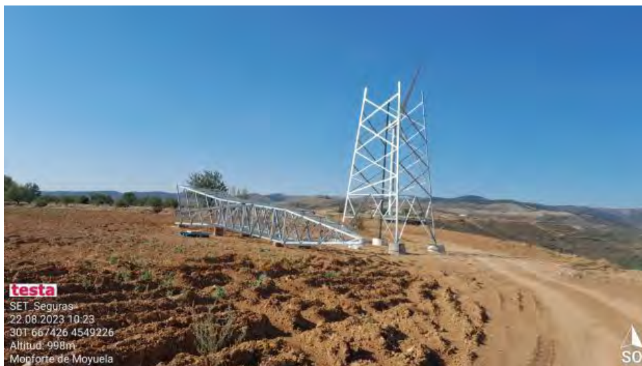
Montaje de apoyo.
