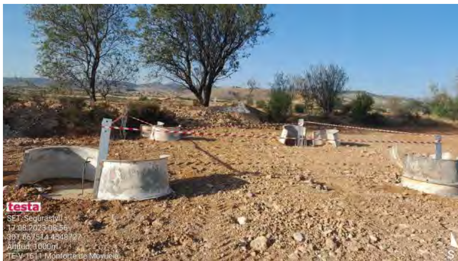
Nueva cimentación en LAT Seguras.
