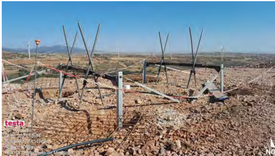
Nueva cimentación en LAT Seguras AP-4.
