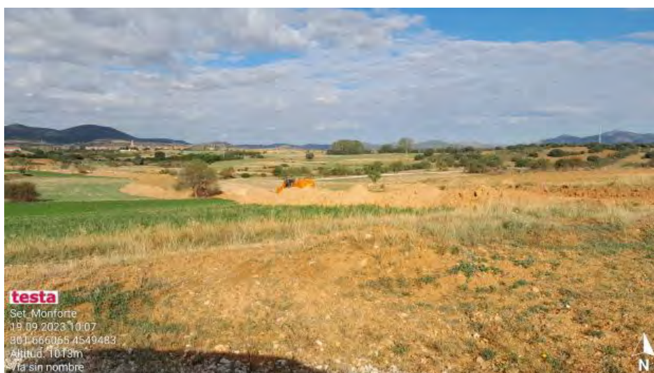
Zanja de evacuación en SET Monforte.
