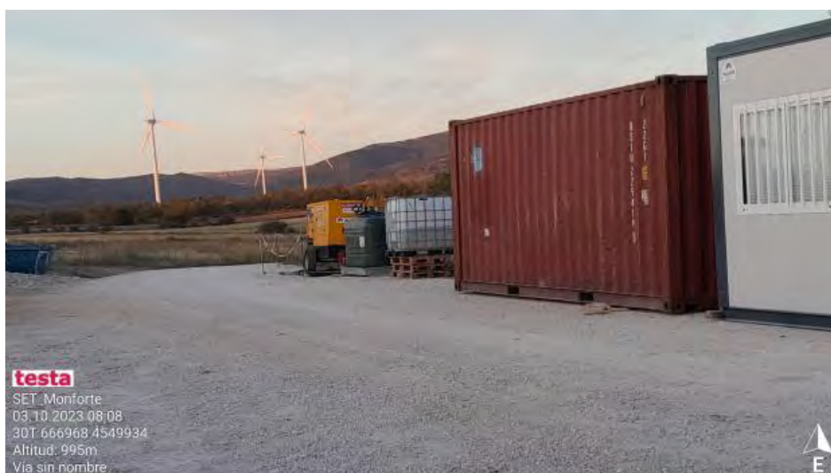
Localización de generador y depósito provisional
