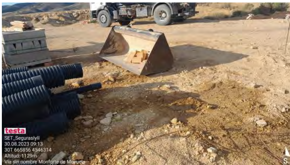
Derrame en punto limpio .
