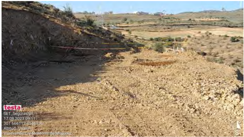
Preparación para hormigonado en AP-3 LAT Seguras
