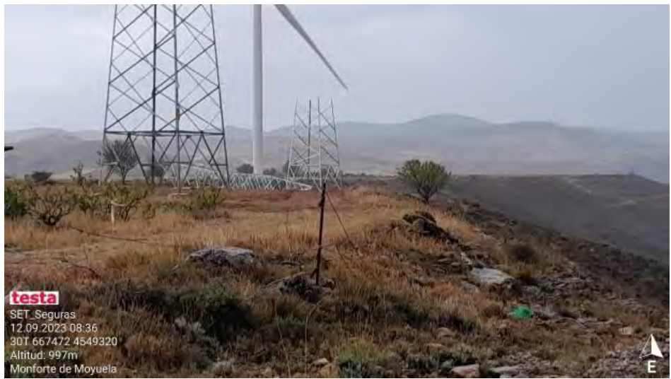
Montaje de apoyo.
