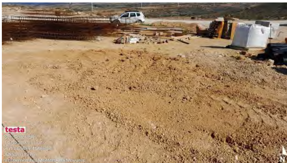
Extendido de zahorra sobre manchas y derrames en punto limpio .
