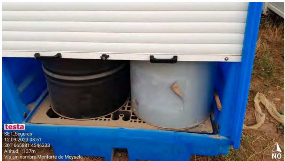
Contenedor sin cerrar
