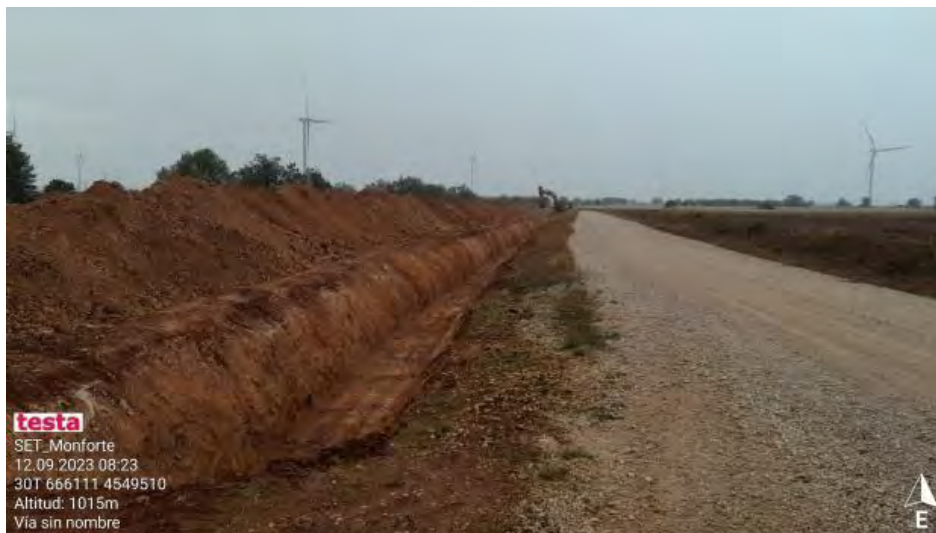
Zanja de evacuación en SET Monforte.
