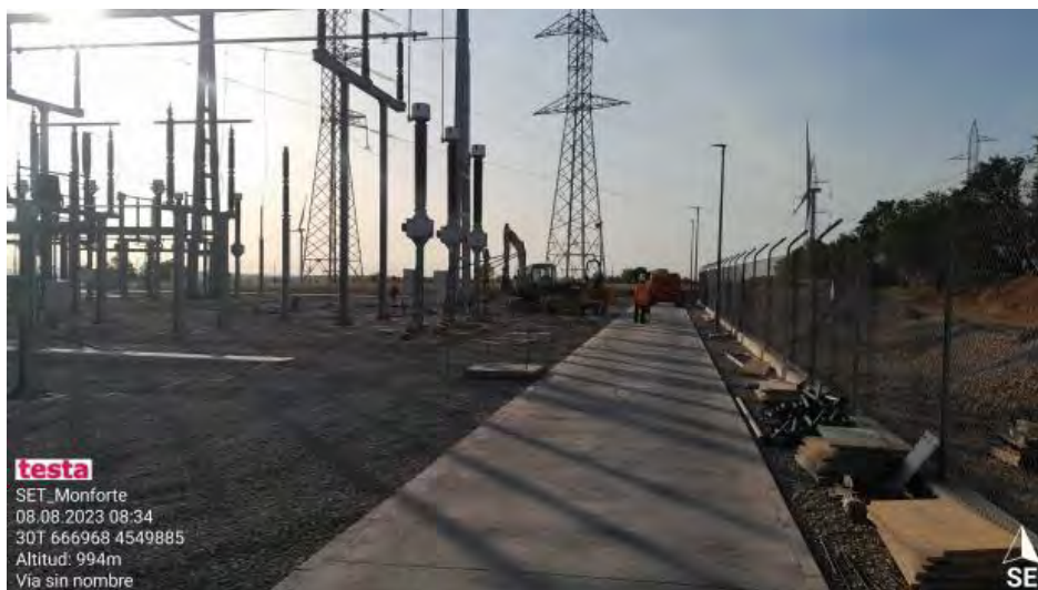
Trabajos en SET Monforte
