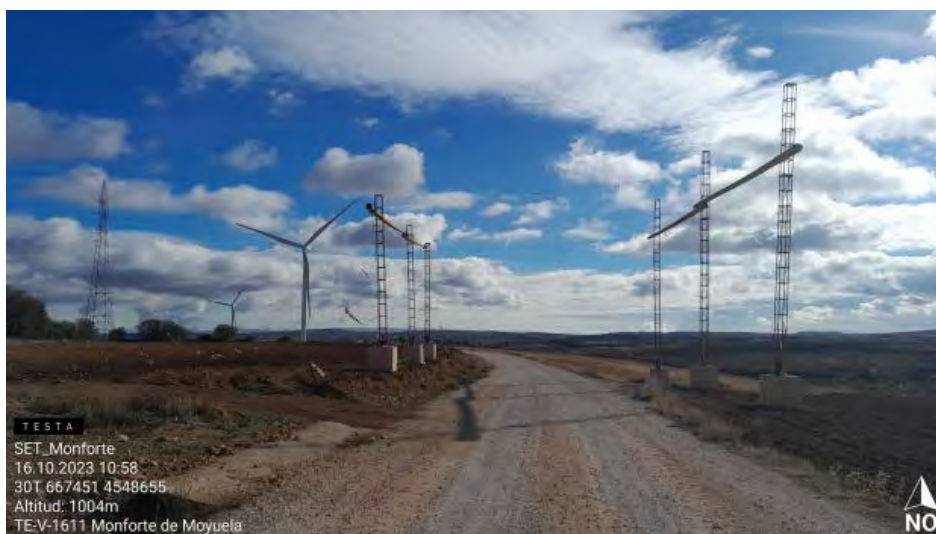
Cableado en LAT
