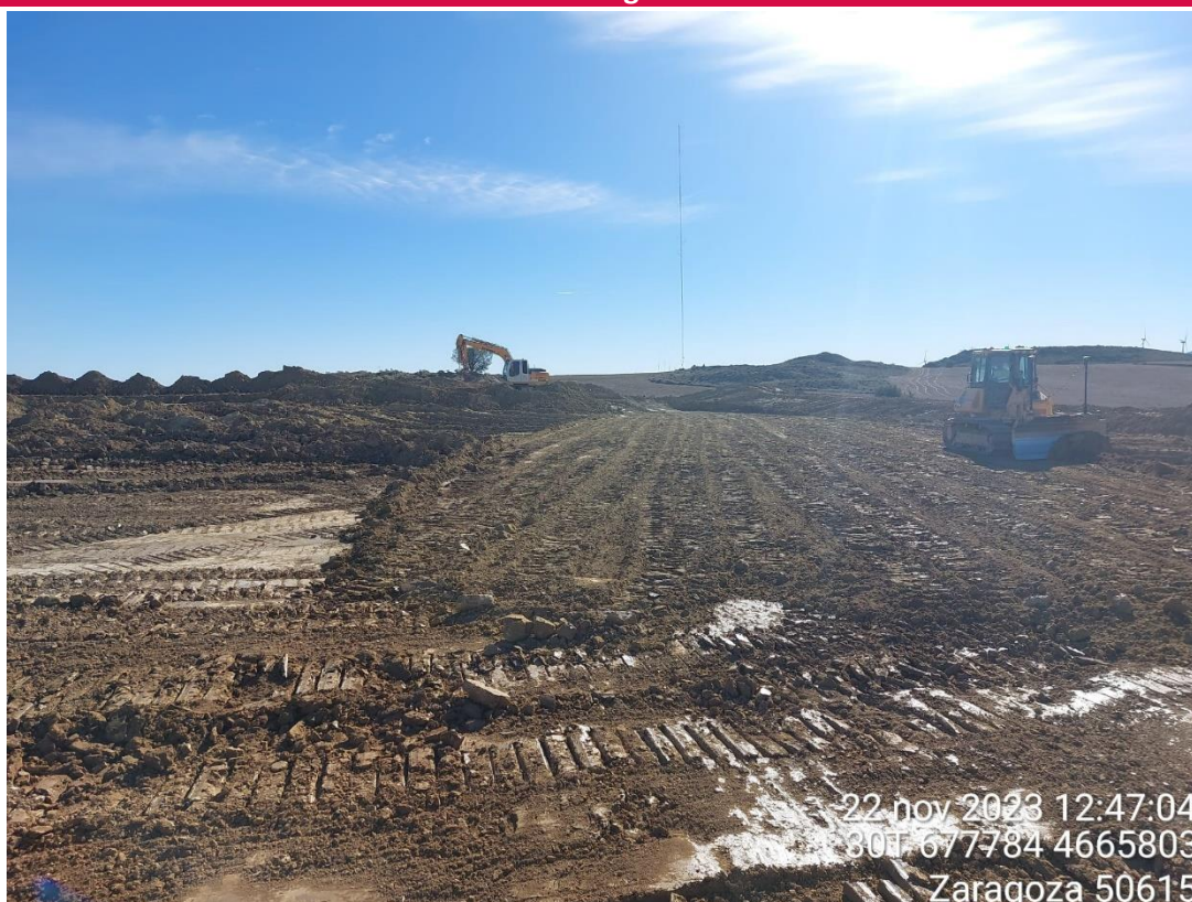
Imagen 1. Trabajos en SET San Licer II.
