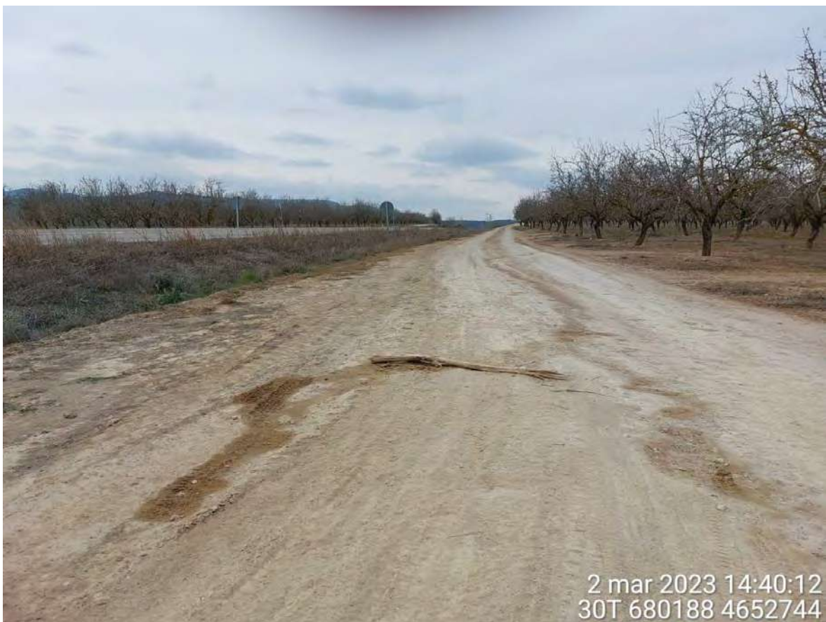
Imagen 3. Mancha de aceite en vial de OBII-03. Se debe recoger y actuar de forma rápida.
