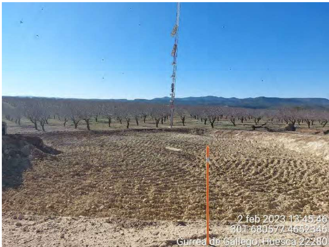
Imagen 3. Excavación en OBII.
