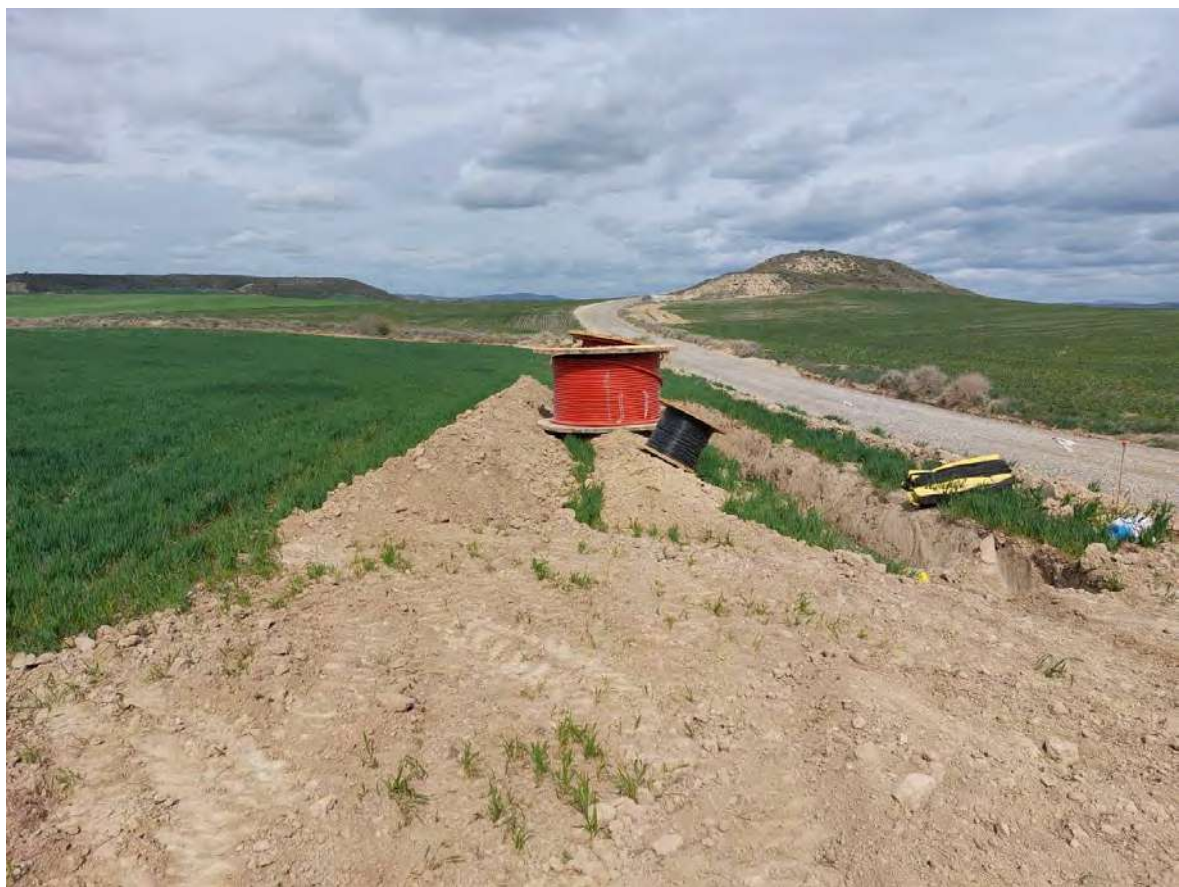
Imagen 1. Zanja de evacuación OBIII.
