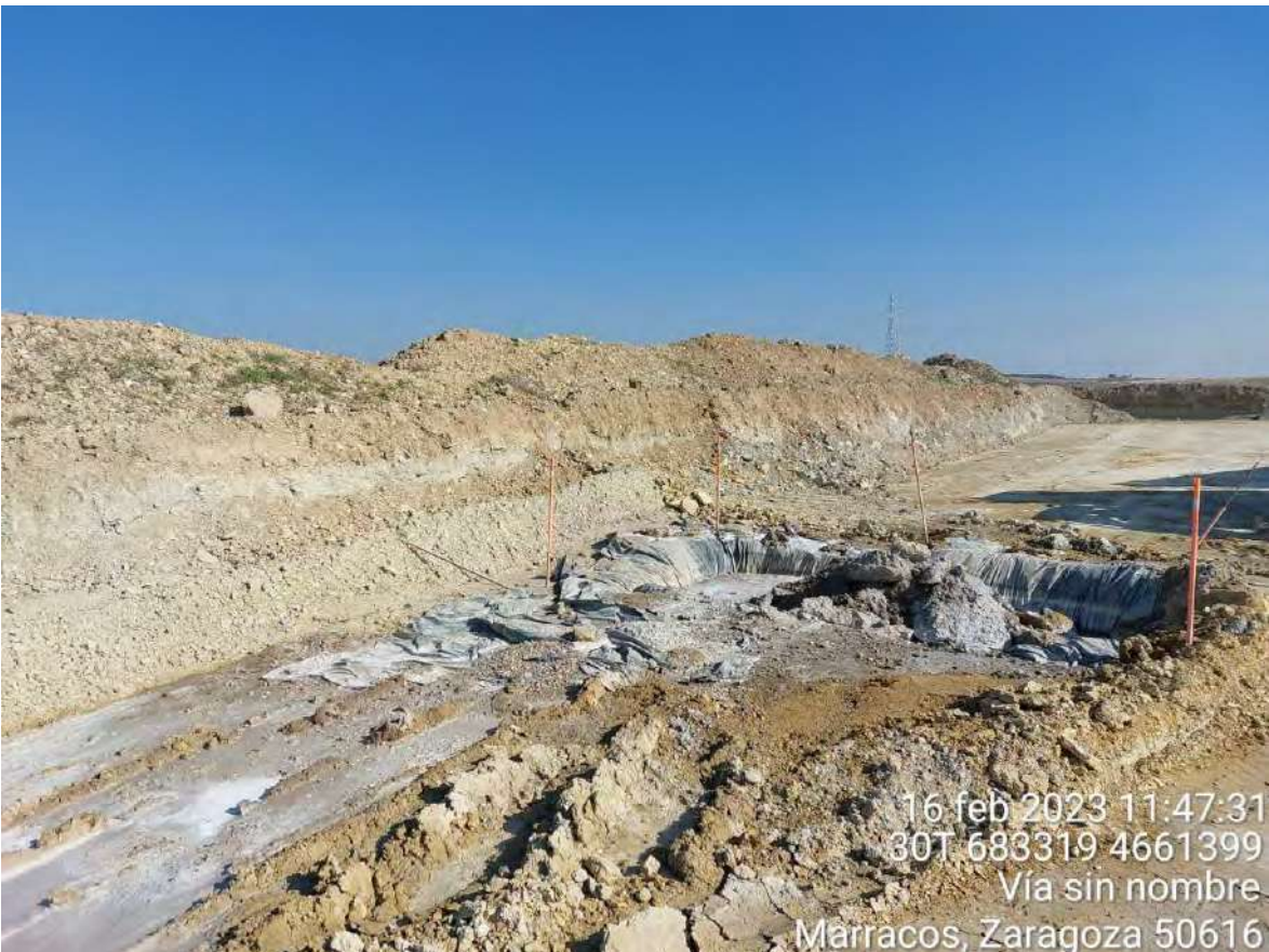
Imagen 3. Tierra manchada de agua con hormigón en OBIII-02.
