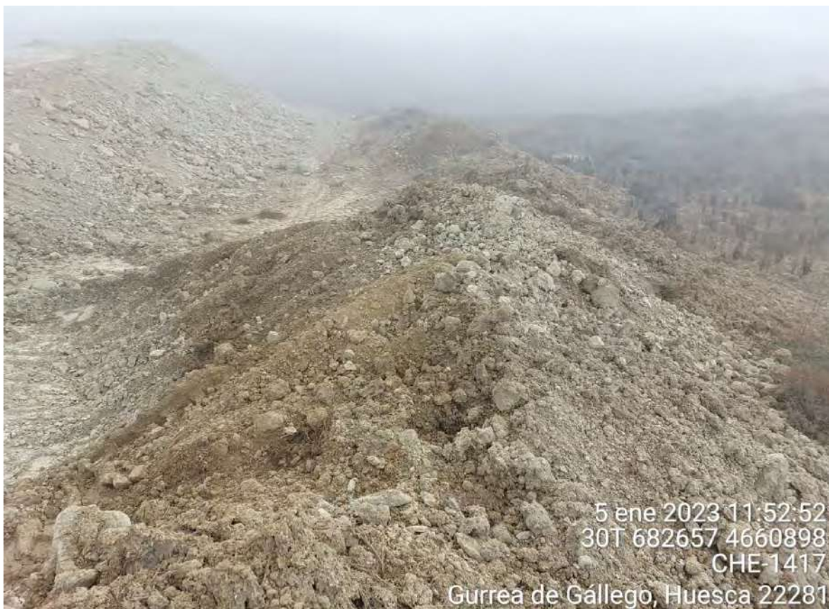
Imagen 2. No conformidad leve. Incorrecta separación de la tierra vegetal del resto del material extraído en OBIII-02.
