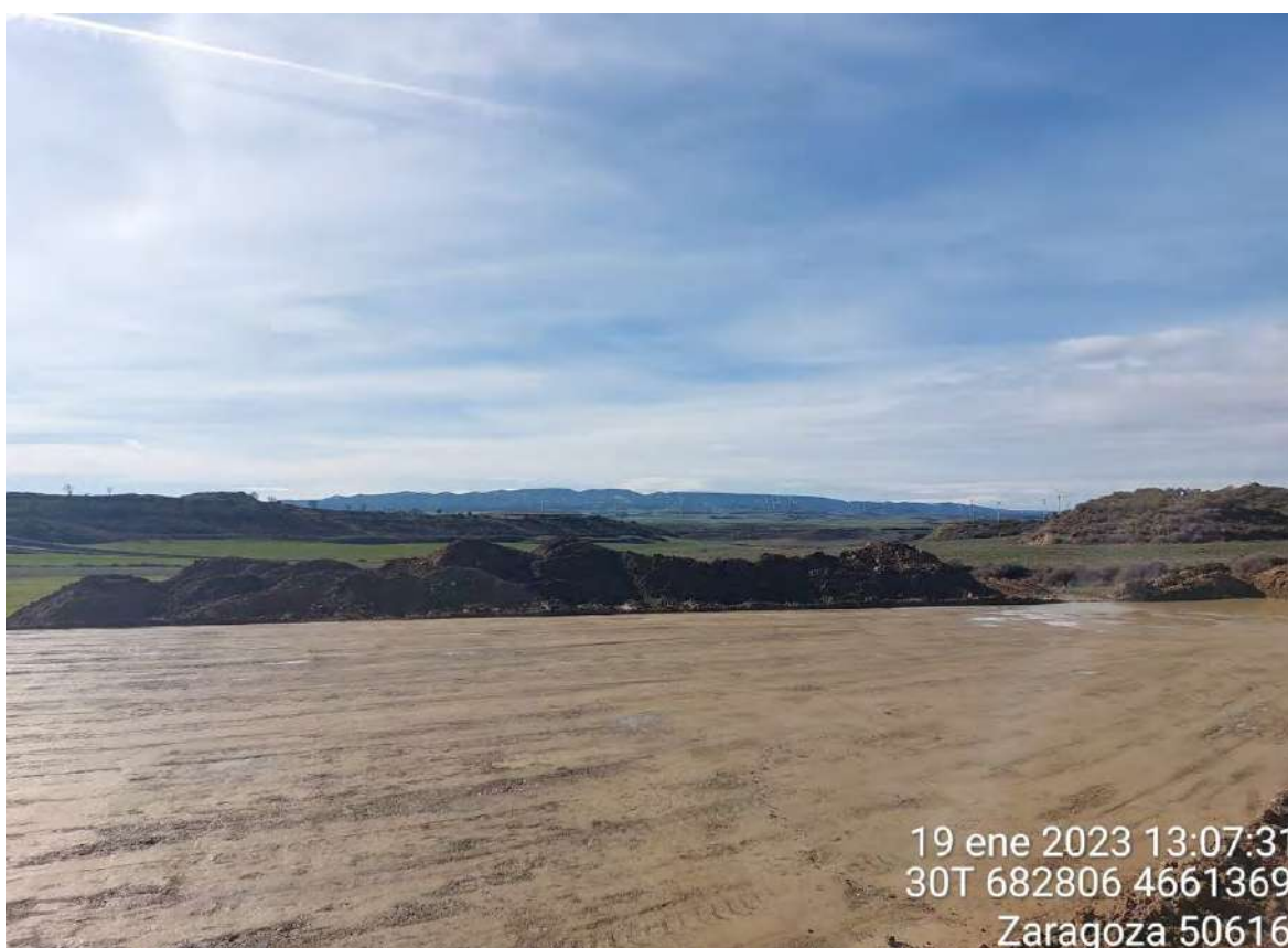
Imagen 1. Acopio de tierra vegetal en la zona de la TM de OBIII. Los cordones son mucho mayores de 1,5 m.
