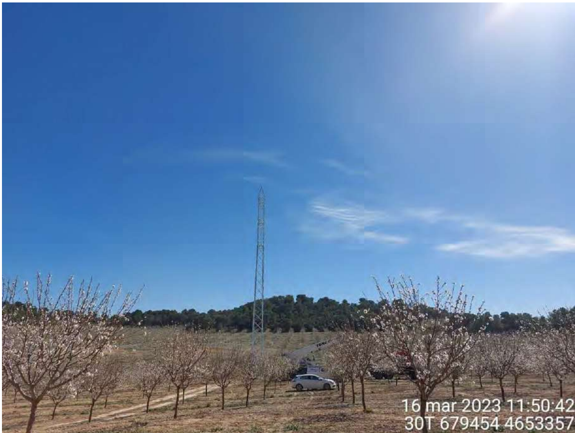
Imagen 2. Apoyo 48 en montaje.
