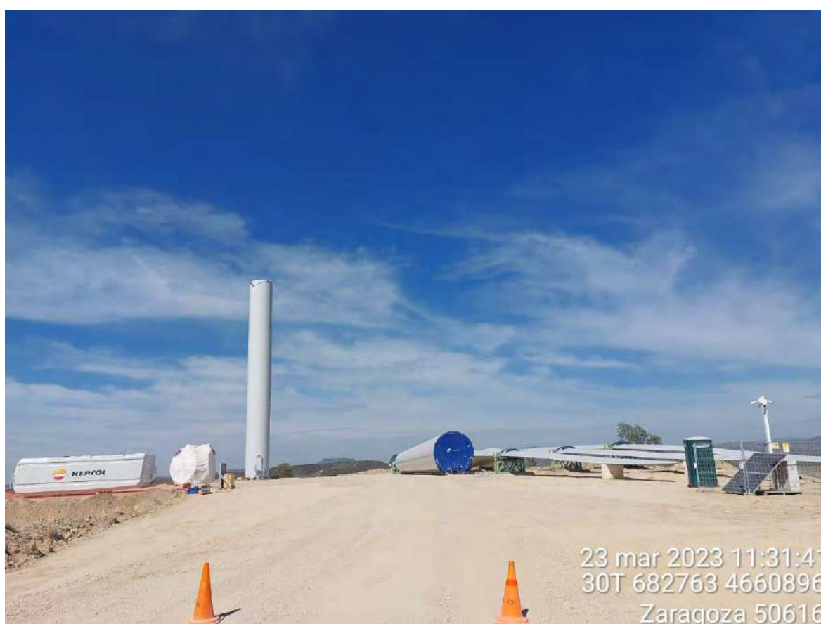
Imagen 1. Posición OBIII-02 con el material acopiado en plataforma.
