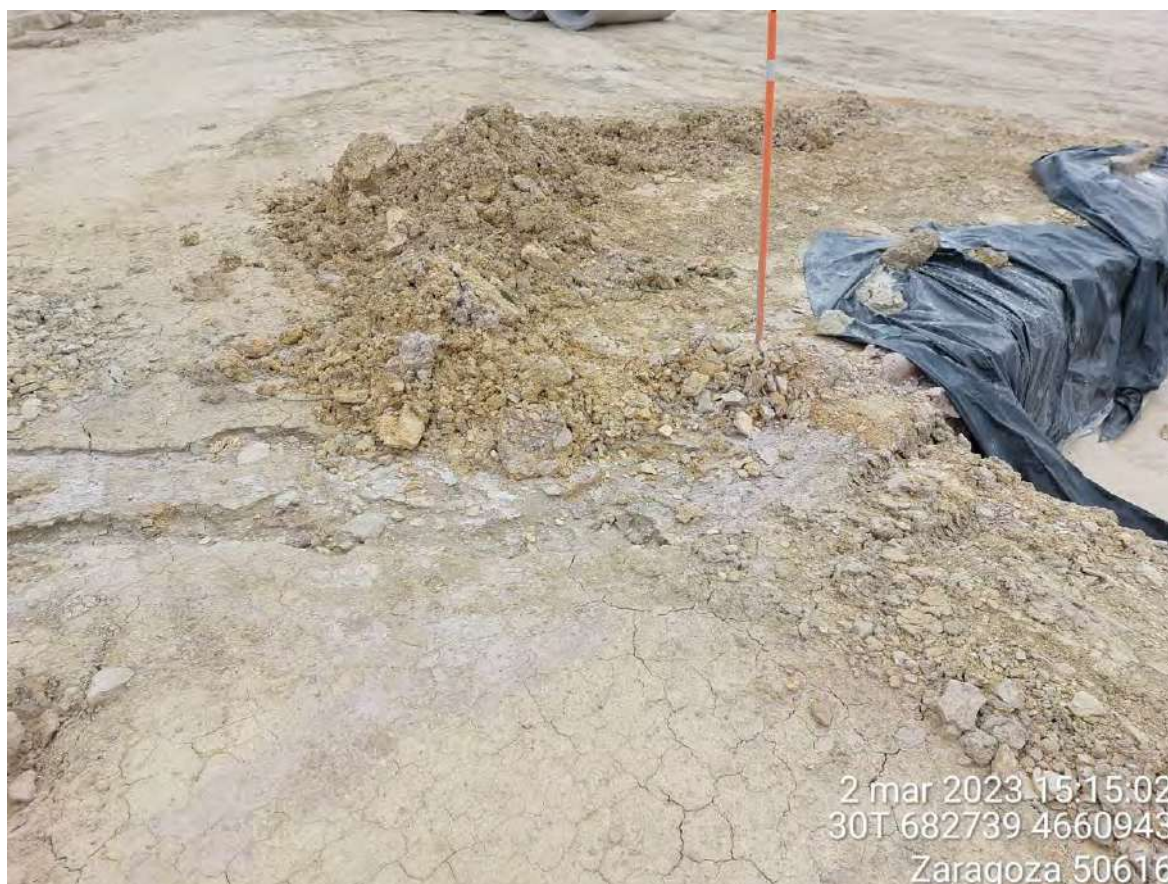
Imagen 1. Suelo contaminado de residuo de hormigón en OBIII-02.
