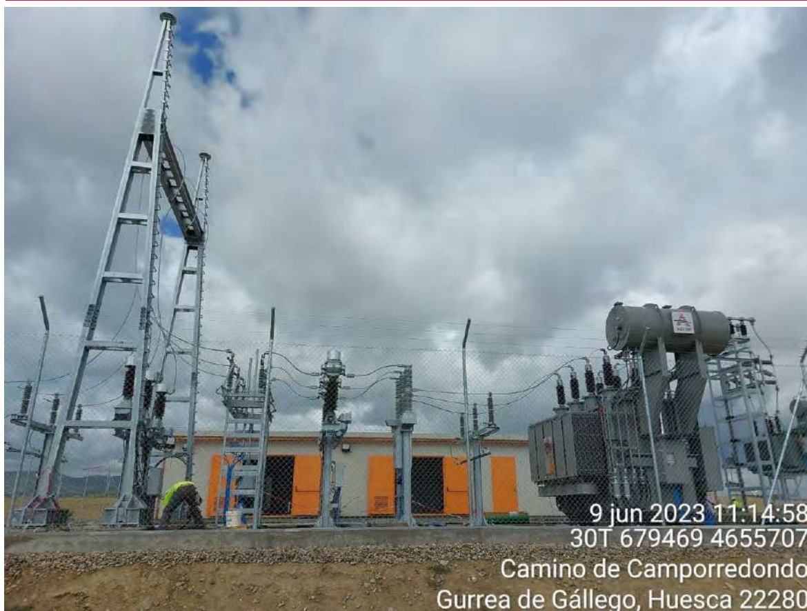
Imagen 1. Trabajos en SET.
