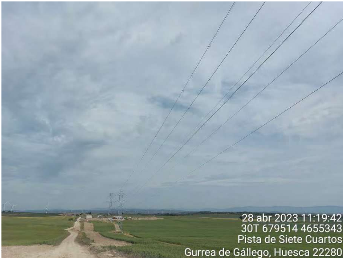
Imagen 1. Línea de alta tensión con los salvapájaros instalados.
