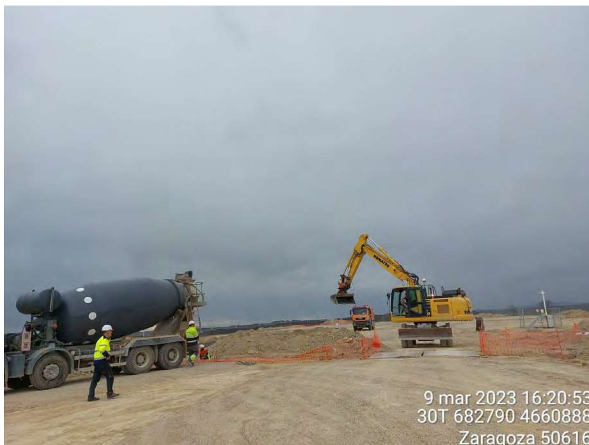
Imagen 1. Maquinaria preparando OBIII-02.
