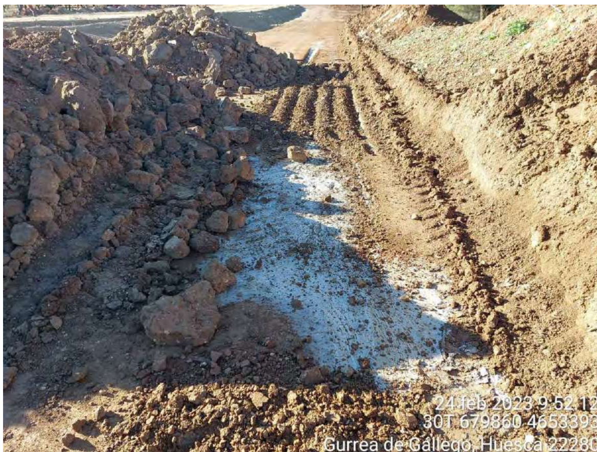
Imagen 1. Residuo de hormigón en el pozo de lavado que se restauró y limpió incorrectamente. Cuando se limpie y se gestione correctamente se cerrará la NC.
