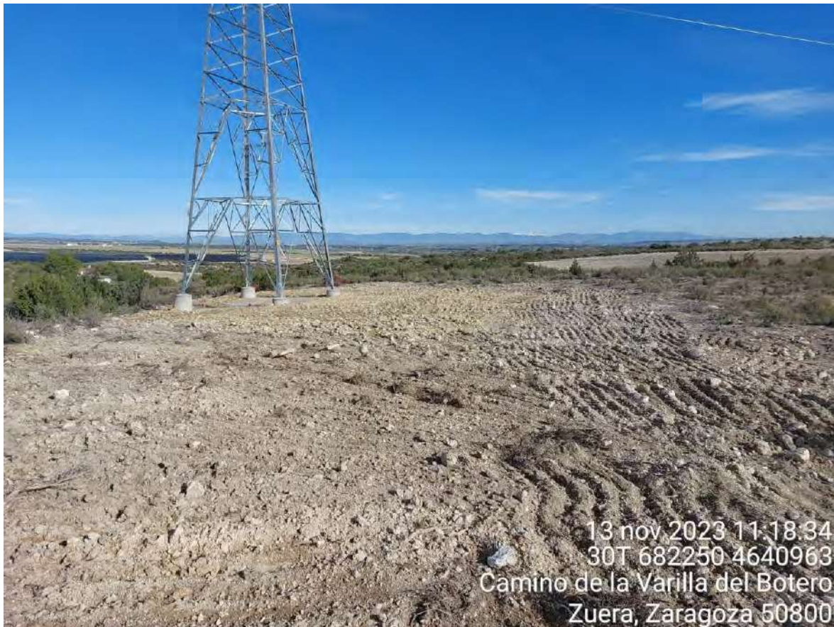
Imagen 3. Apoyo 98 restaurado morfológicamente.
