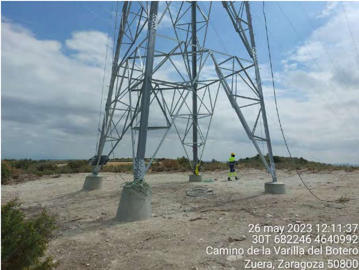
Imagen 1. Trabajos en apoyo de la LAT
