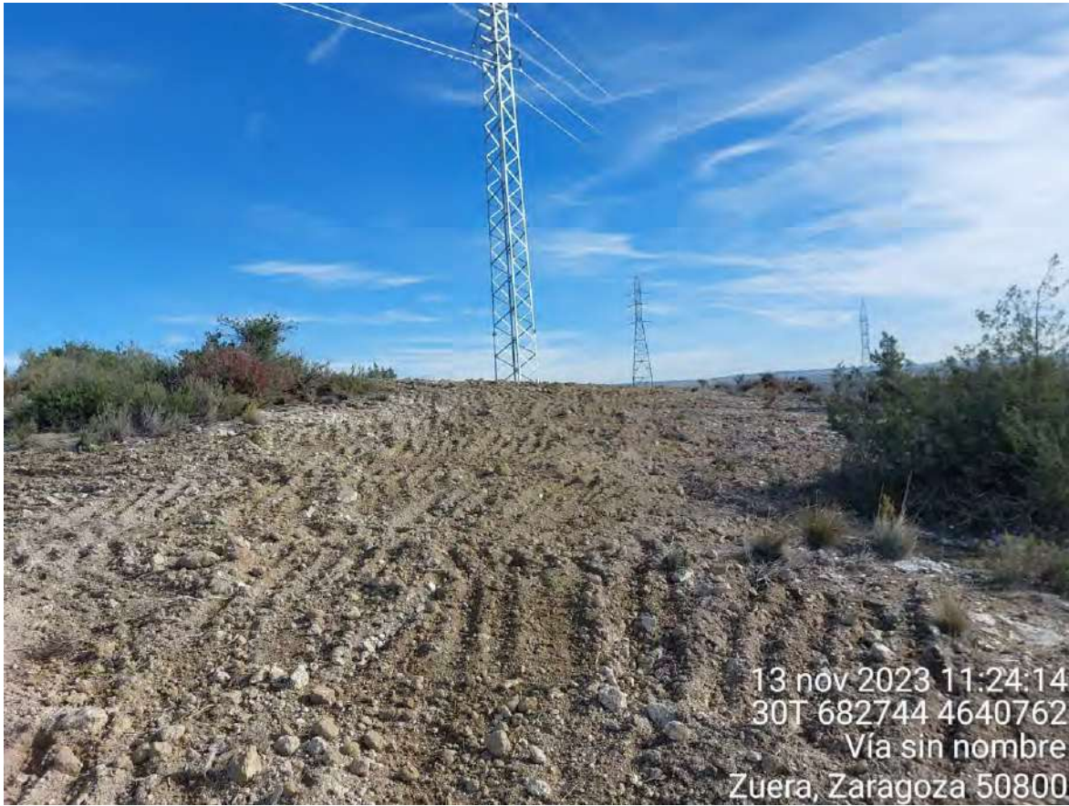
Imagen 1. Apoyo 100 restaurado morfológicamente.
