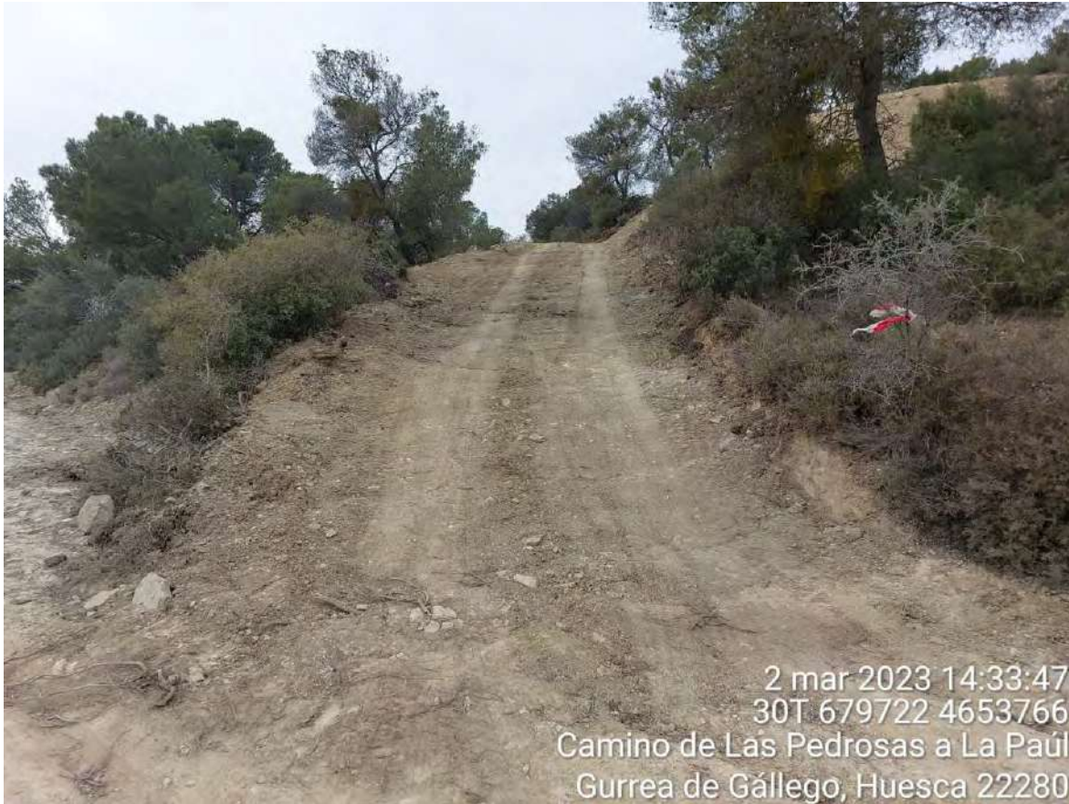
Imagen 4. Entrada al apoyo 46 tras realizar los trabajos de tala y desbroce.
