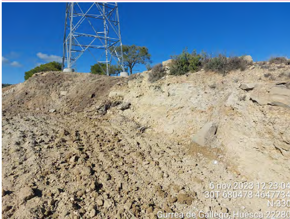
Imagen 1. Apoyo 71 sobre el que se deben realizar trabajos de rebajar pendiente y crear talud.
