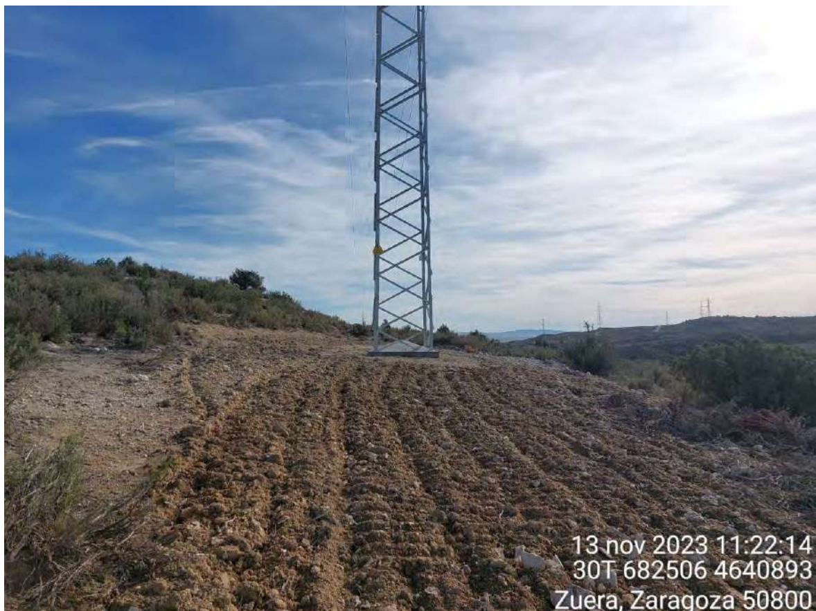
Imagen 4. Apoyo 99 restaurado morfológicamente.
