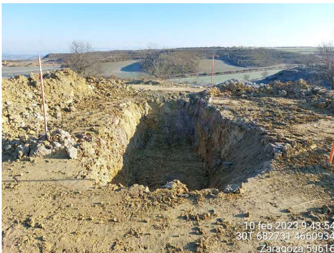
Imagen 1. Pozo de lavado utilizado en proceso de restauración.
