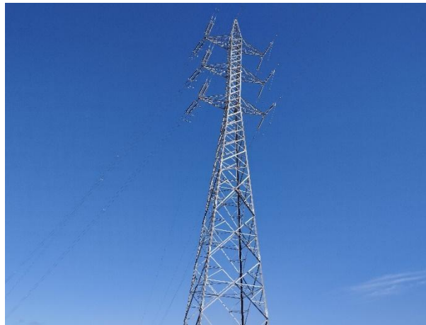
Fotografías 5 a 8: Apoyos de celosía y tendido con salvapájaros
