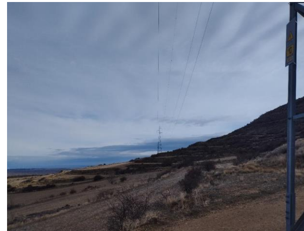
Fotografías 5 a 8: Apoyos de celosía y tendido con salvapájaros
