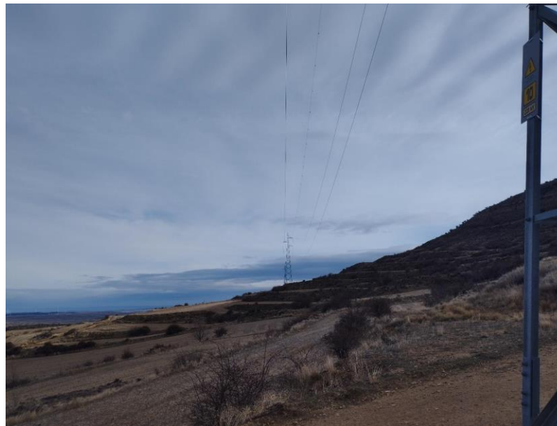
Fotografía 9: Señalización en apoyo
