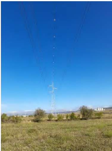
Fig 1. Balizas salvapájaros en el vano número 6
