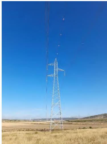
Fig 2. Balizas salvapájaros en el vano número 10
