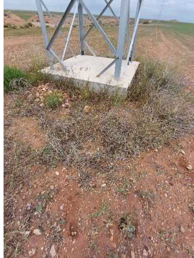
Imagen 7. La base y el entorno de los apoyos de la LAAT continúan siendo colonizados de manera espontánea por vegetación natural
