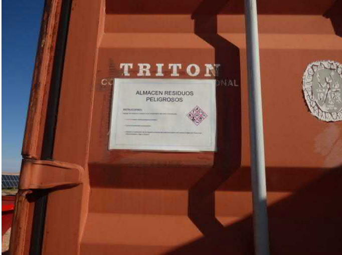
Imagen 8. Depósitos homologados e identificados conforme a la normativa vigente para el almacenamiento temporal de residuos peligrosos
