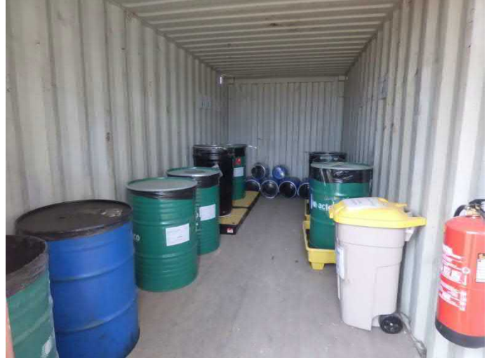
Imagen 8. Depósitos homologados e identificados conforme a la normativa vigente para el almacenamiento temporal de residuos peligrosos
