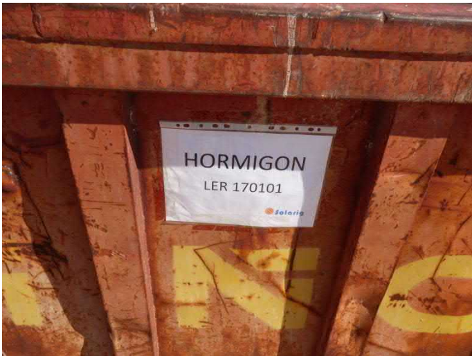
Imágenes 13 y 14. Etiquetado del contenedor del residuo no peligroso "hormigón" (foto izquierda). Residuos en el interior del contenedor (foto derecha).
