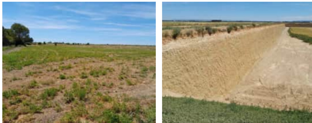
Figura nº 9. Fotos realizadas en la zona del préstamo ZP y frentes de otras zonas de explotación próximas
