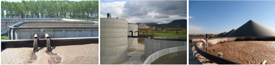
Figura46. Imágenes de procesos de nitrificación/desnitrificación
