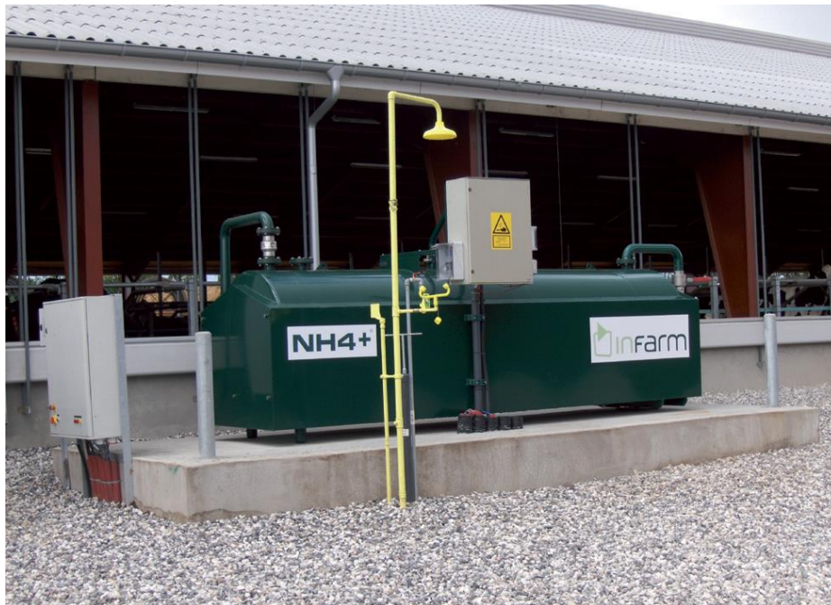
Figura 31. Unidad de acidificación Infarm ©Lanbrugsavisen.
