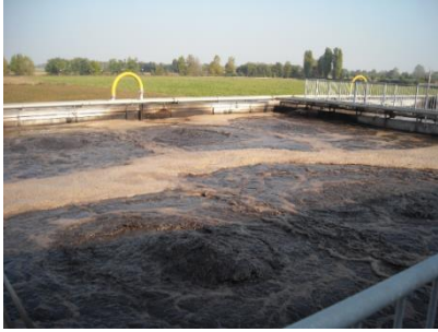
Figura 45. Línea de proceso de un tratamiento de nitrificación/desnitrificación. Configuración SBR en un único tanque con ciclos de aireación secuenciales (Provolo et al., 2015 Proyecto LIFE+ MANEV).
