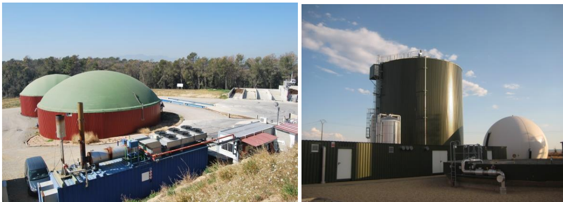
Figura 34. Plantas de codigestión de ViladeMuls (Cataluña) con purín bovino y de Almazán (Castilla y León) con purín porcino.
