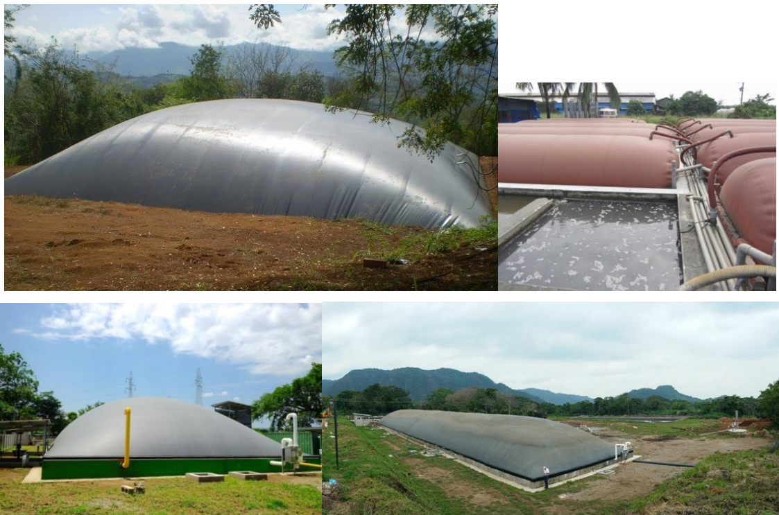
Figura 37. Imágenes de sistemas de digestión anaerobia instalados en los sistemas de almacenamiento de purín en explotaciones ganaderas.
