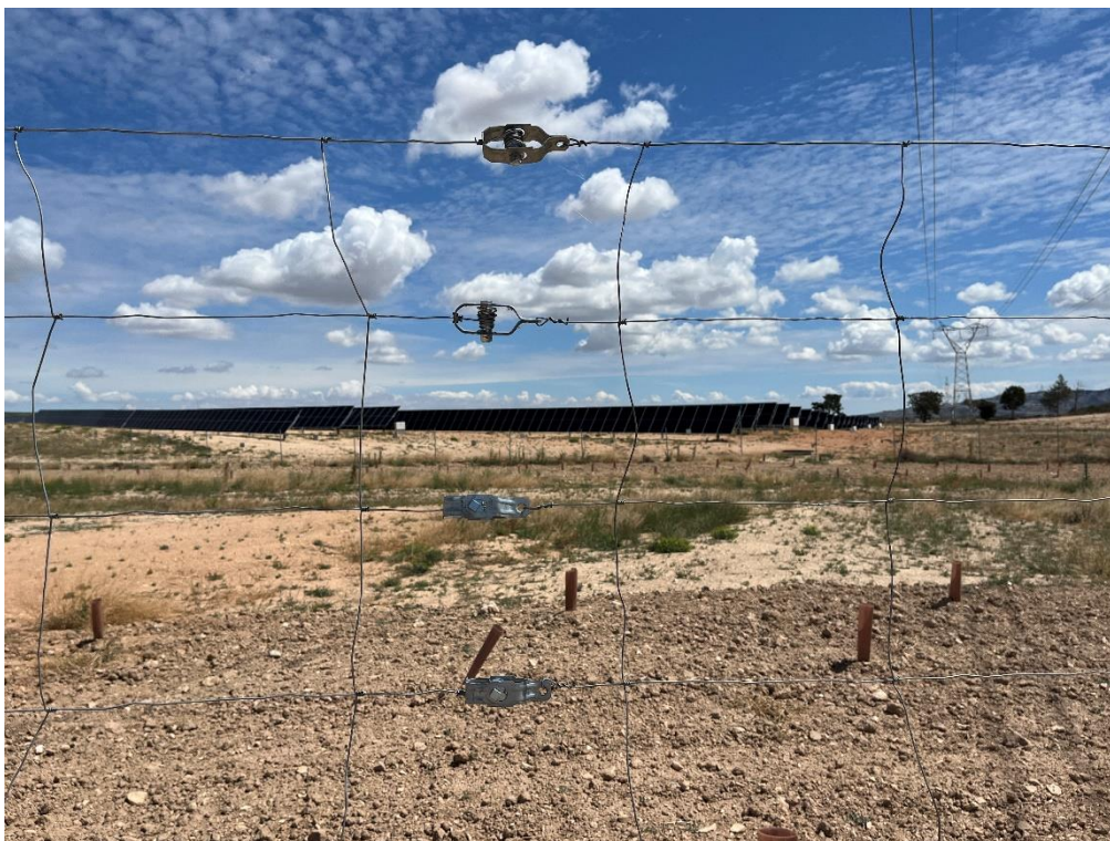
Figura 4 Vallado sin elementos punzantes
