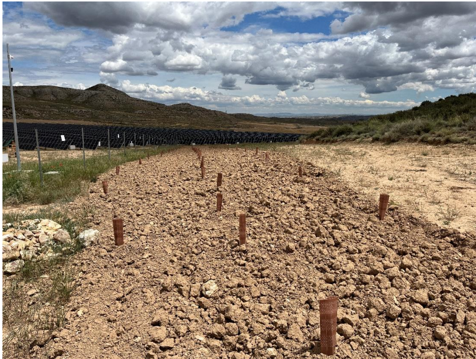
Figura 2 Ejecución de pantalla vegetal
