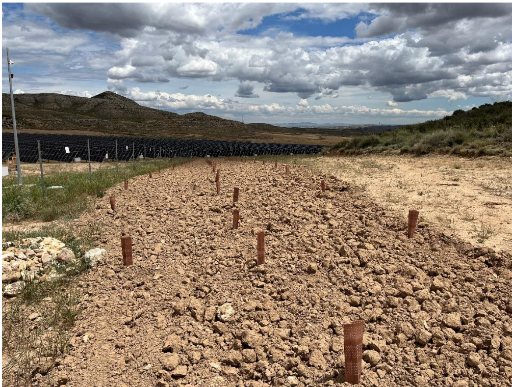
Figura 7 Ejecución de la pantalla vegetal del vallado
