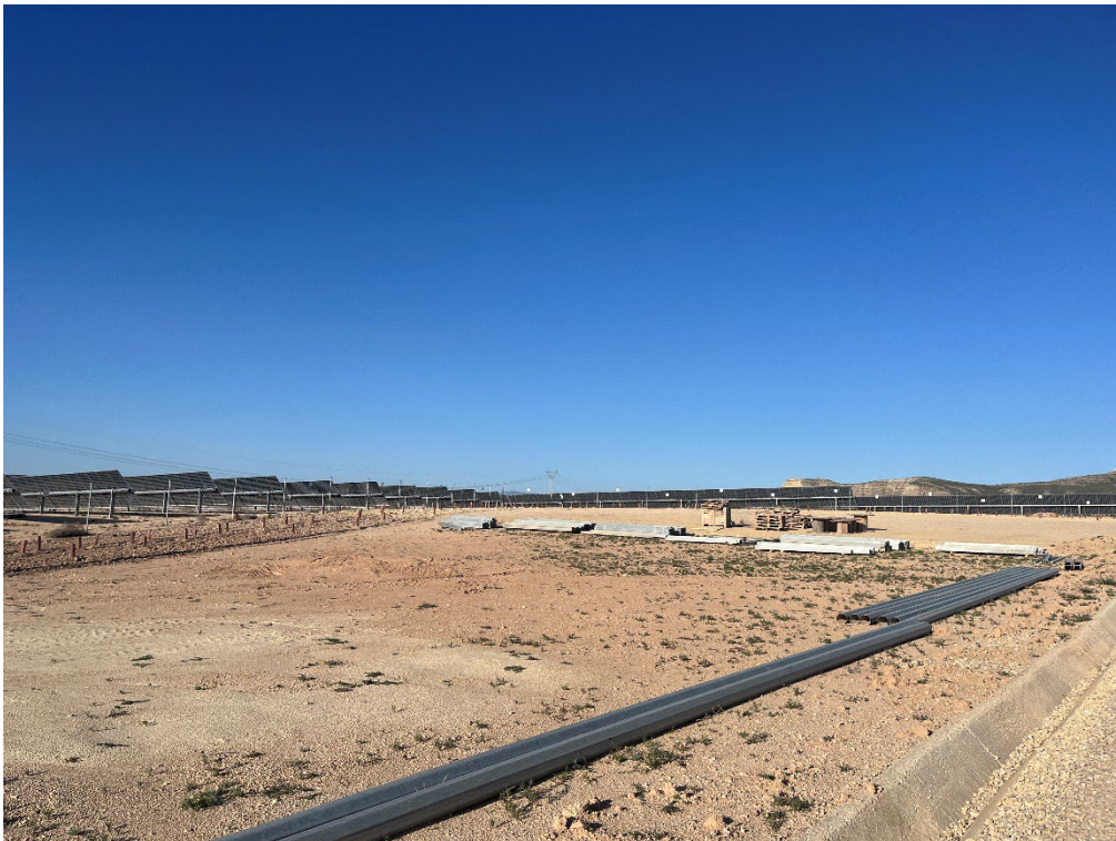
Figura 6 Acopio del material de construcción
