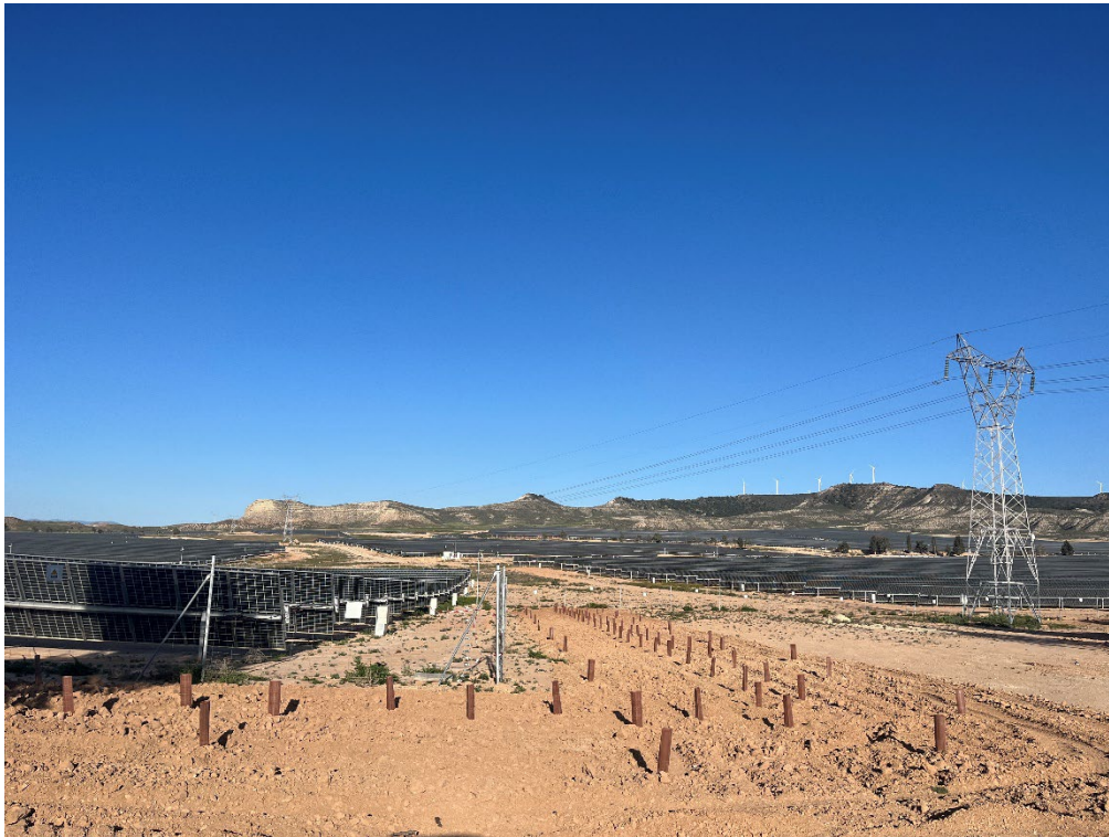
Figura 4 Ejecución de la pantalla vegetal del vallado
