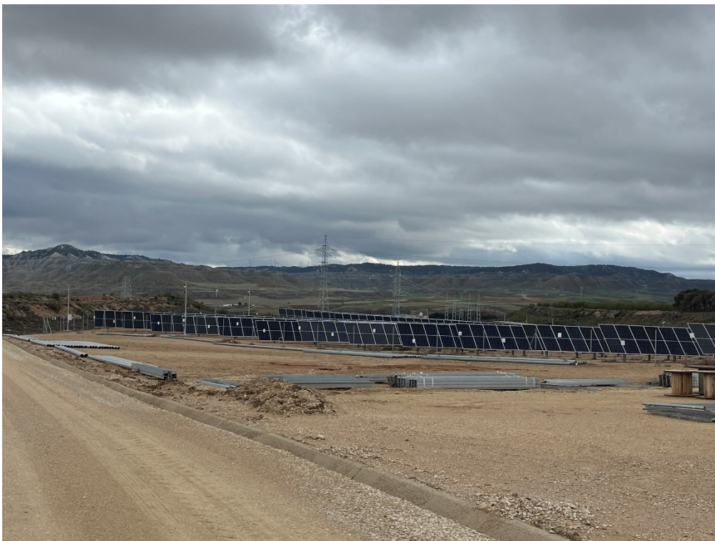
Figura 7 Acopio del material de construcción
