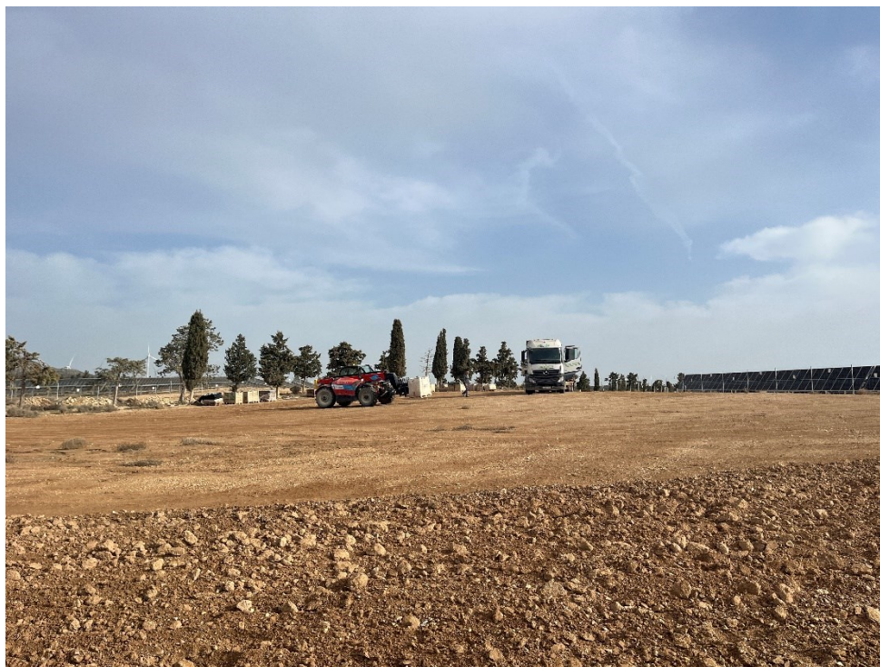
Figura 3 Retirada del punto limpio de residuos no peligrosos
