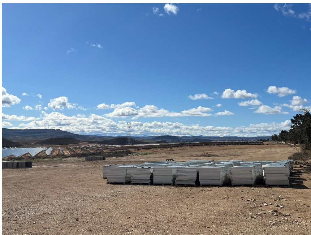
Figura 5 Acopio de material de construcción
