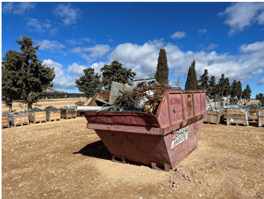
Figura 6 Contenedor para restos de ferralla
