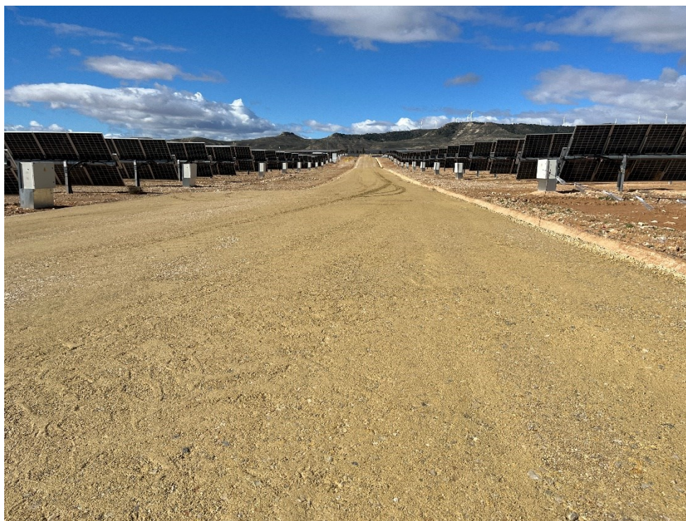
Figura 2 Restauración de los viales
