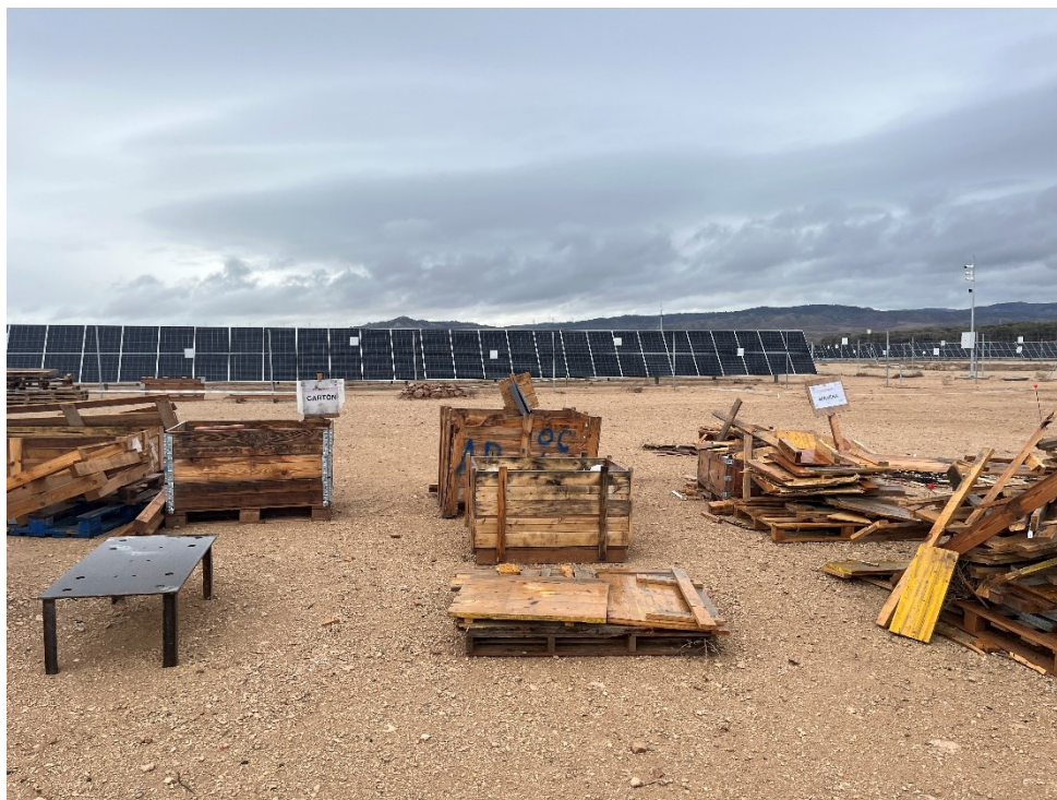
Figura 3 Punto limpio de residuos no peligrosos
