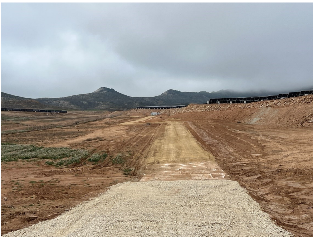
Figura 7 Restauración de los viales
