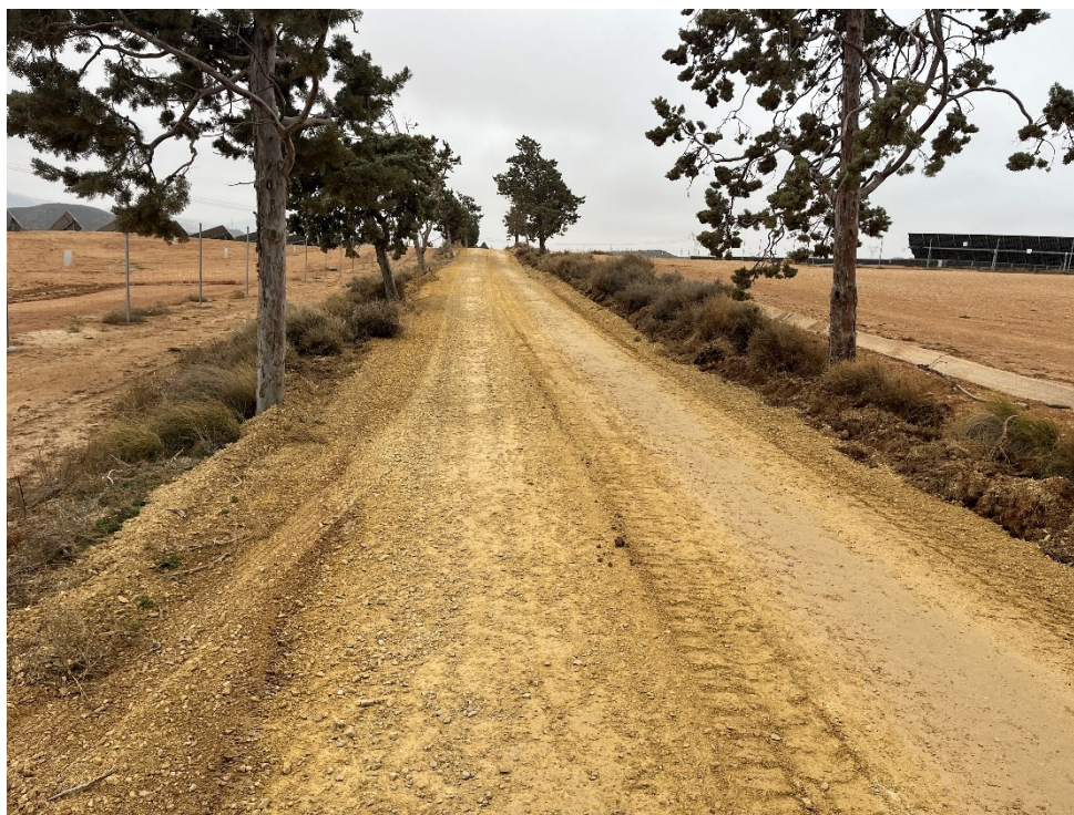
Figura 2 Restauración de los viales
