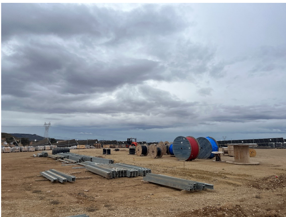
Figura 5 Acopio de material de construcción
