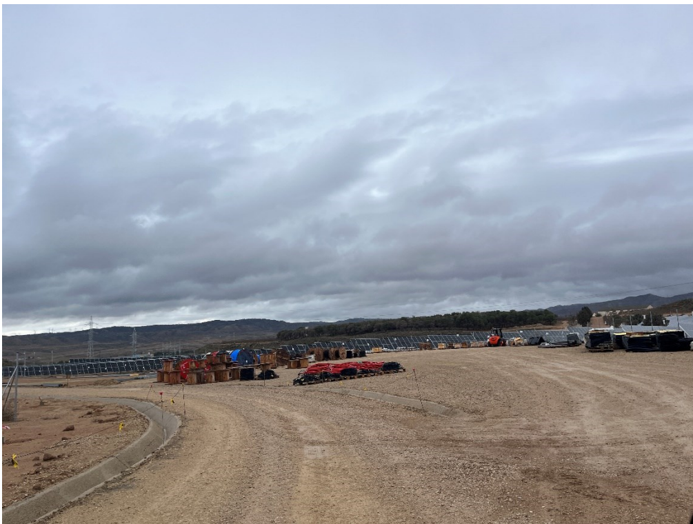
Figura 6 Acopio del material de construcción
