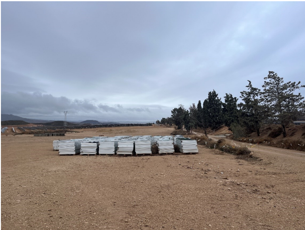
Figura 8 Acopio del material de construcción
