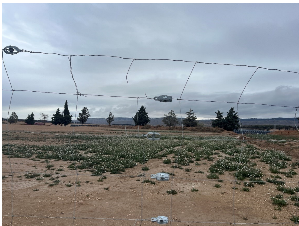
Figura 3 Elementos punzantes del vallado perimetral
