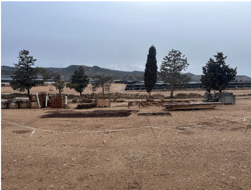
Figura 4 Acopio de restos de ferralla
