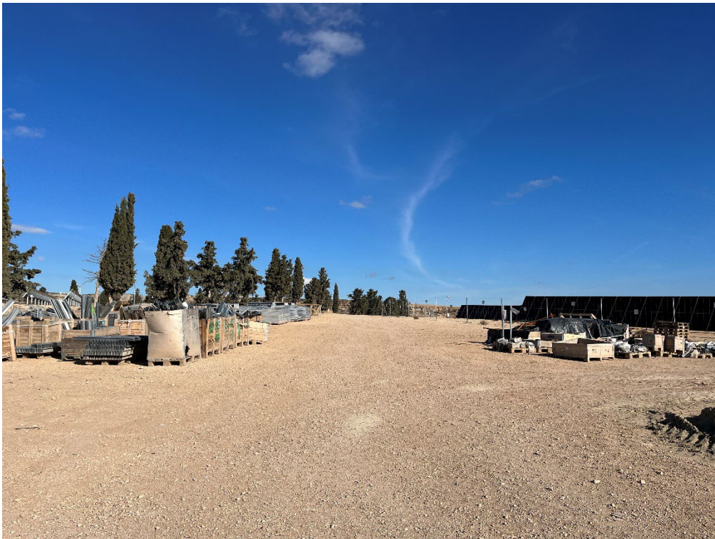
Figura 6 Acopio del material de construcción
