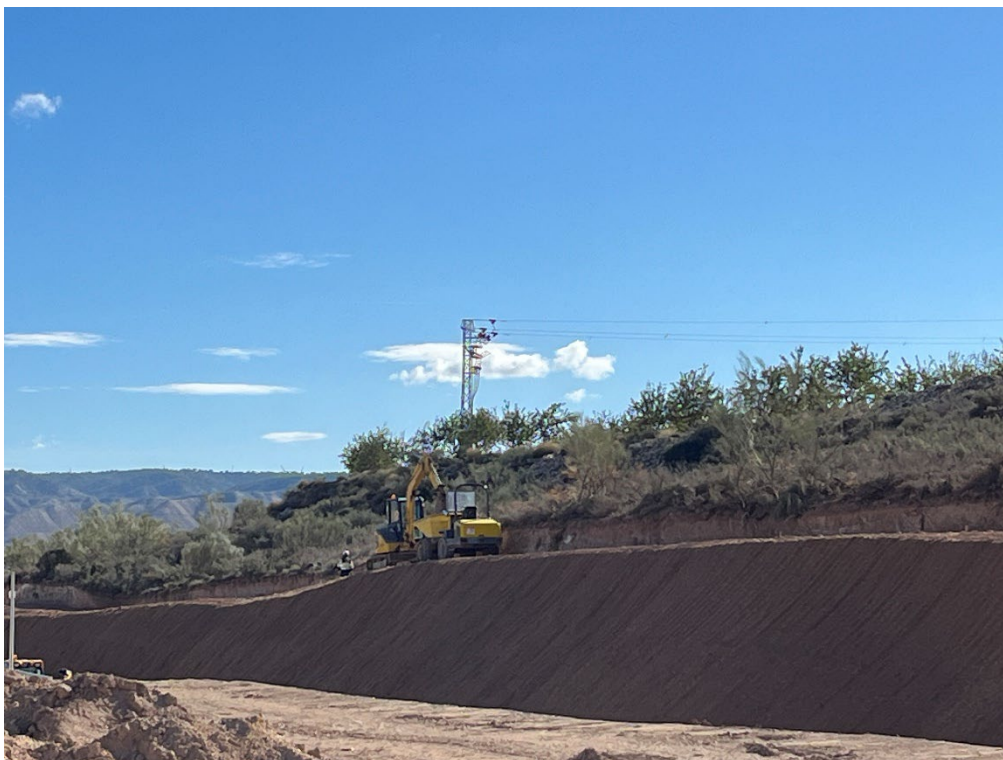
Figura 7 Apertura de cunetas
