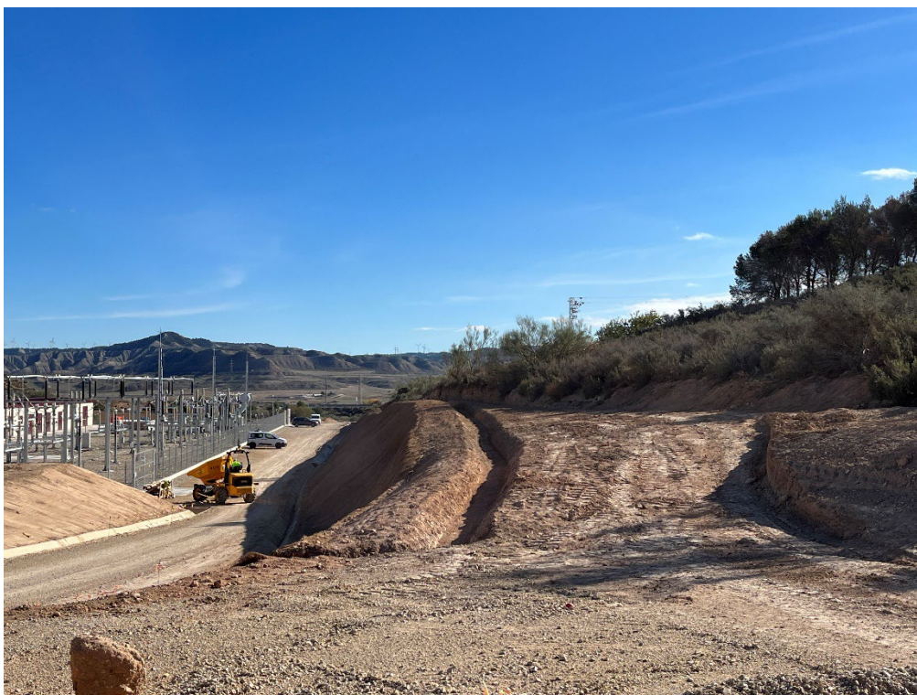
Figura 8 Apertura de cunetas
