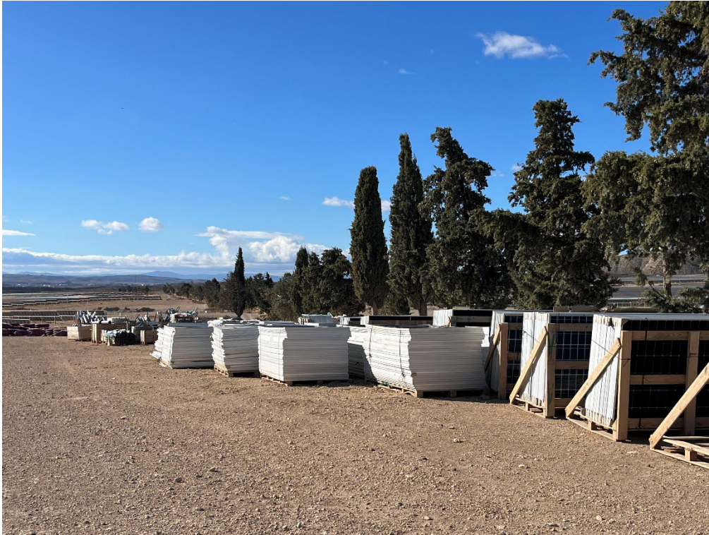
Figura 5 Acopio del material de construcción
