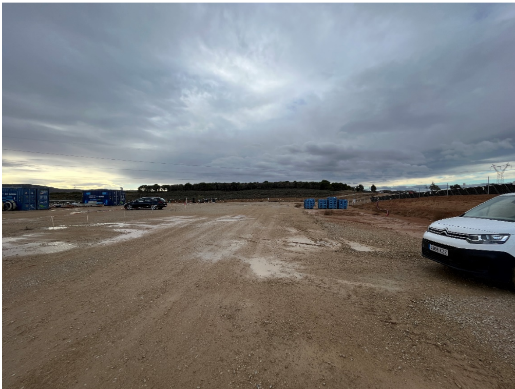
Figura 6 Retirada de las casetas
