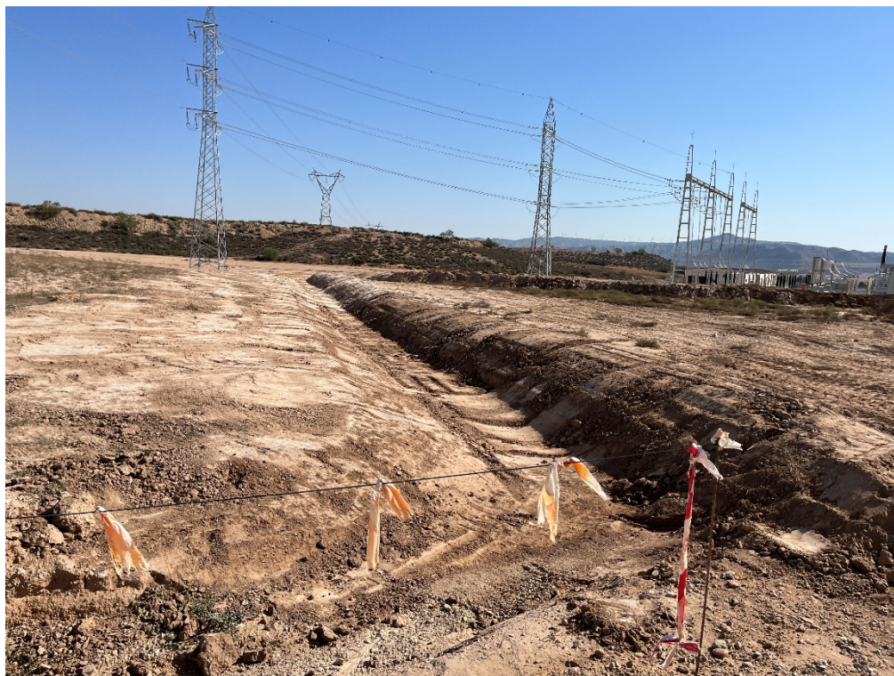
Figura 2 Apertura y cimentación de las cunetas
