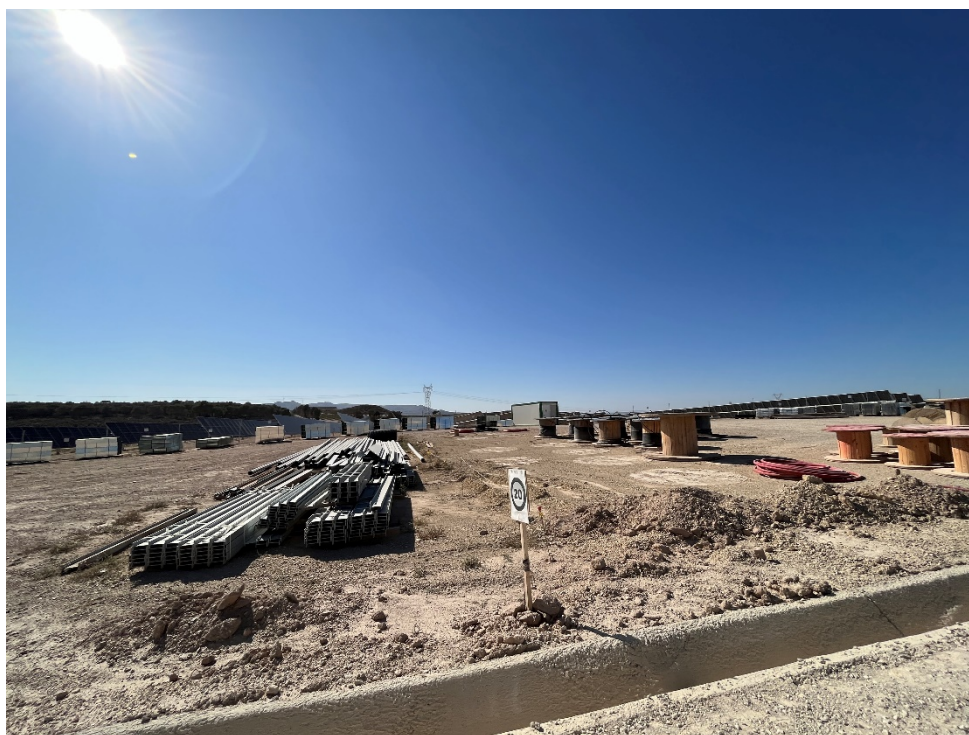
Figura 3 Acopio del material de construcción
