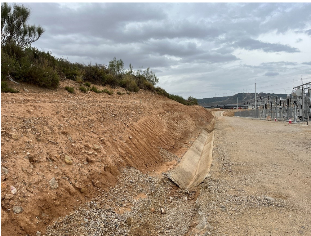
Figura 5 Cimentación de las cunetas SET Vallobar
