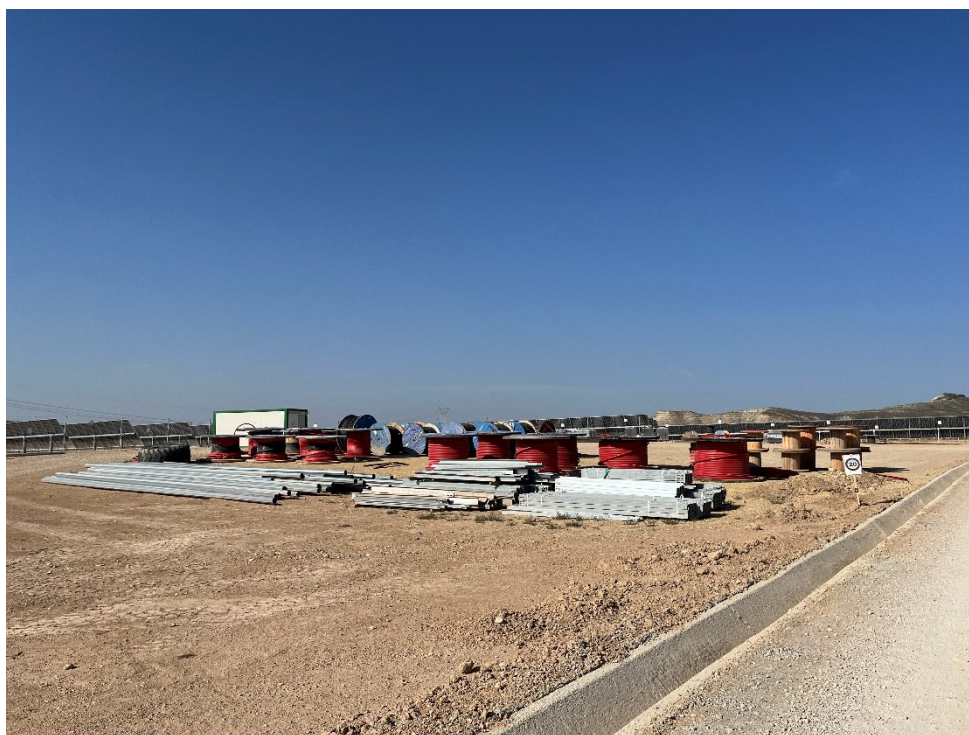
Figura 3 Acopio del material de construcción
