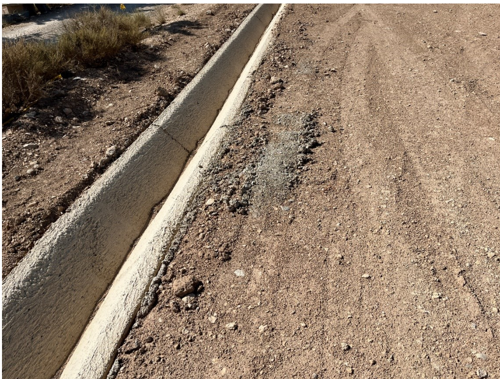
Figura 2 Apertura y cimentación de las cunetas
