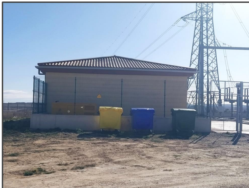
Fotografía 16. Contenedores de residuos junto a la subestación.
