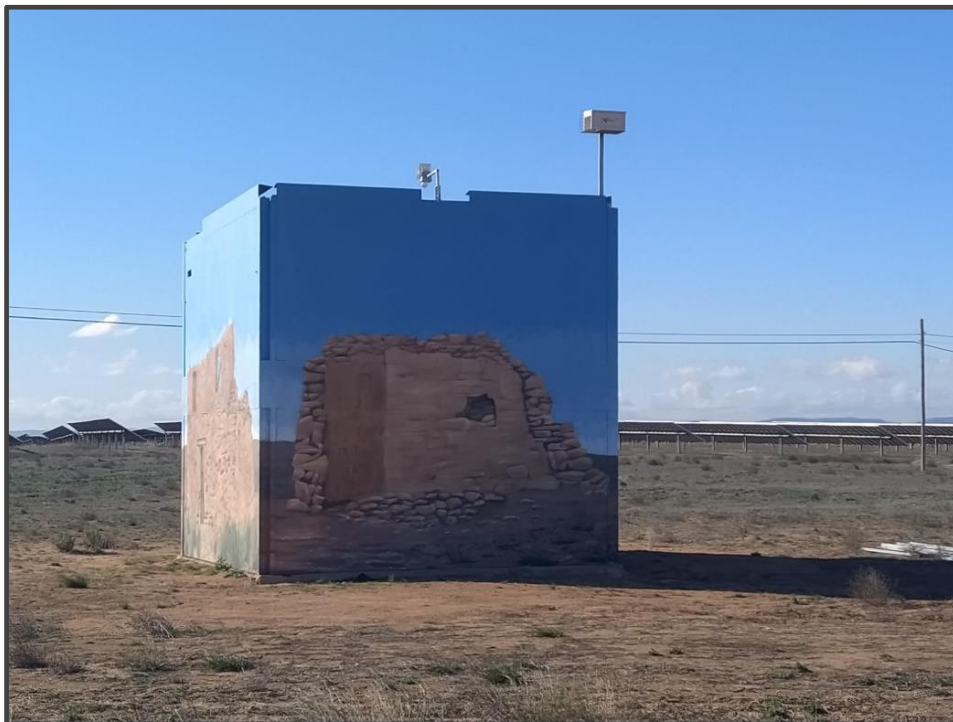
Fotografía 7. Exterior del primillar, pintado.
