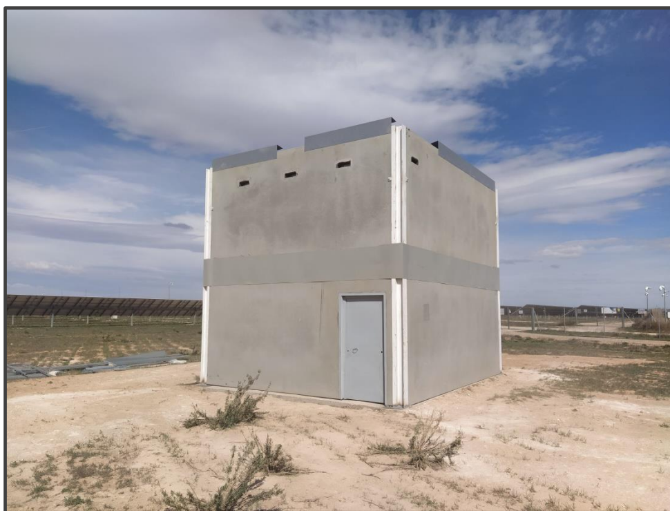
Fotografía 5. Exterior del primillar de nueva construcción.
