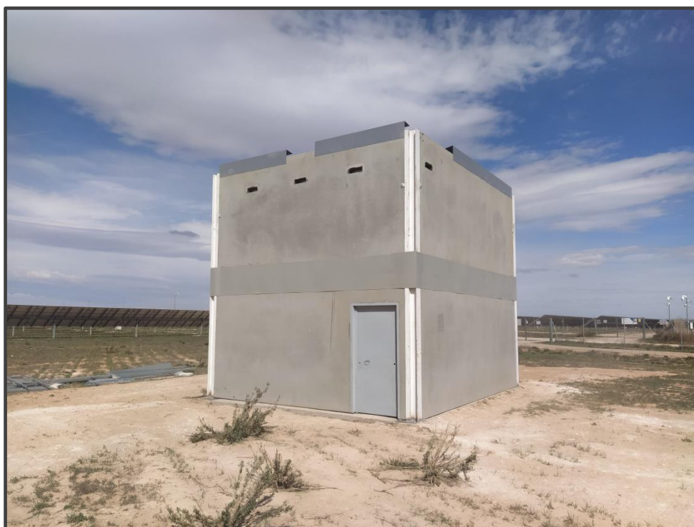
Fotografía 11. Exterior del primillar de nueva construcción.
