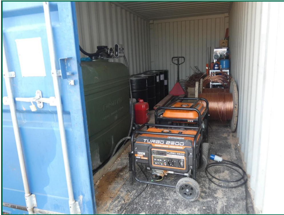
Fotografía 15. Envase de combustible y punto limpio.
