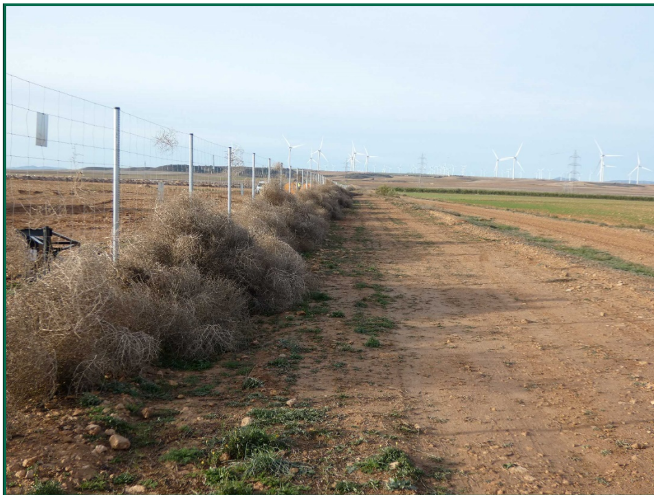
Fotografía 5. Vallado perimetral y placa anticolidión.
