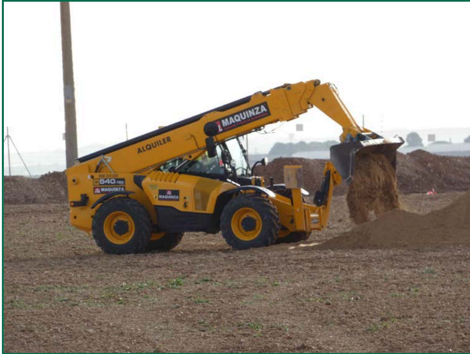
Fotografía 1. Maquinaria de construcción.
