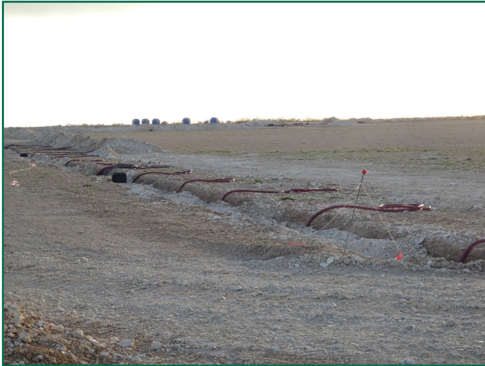
Fotografía 4. Colocación de cableado.
