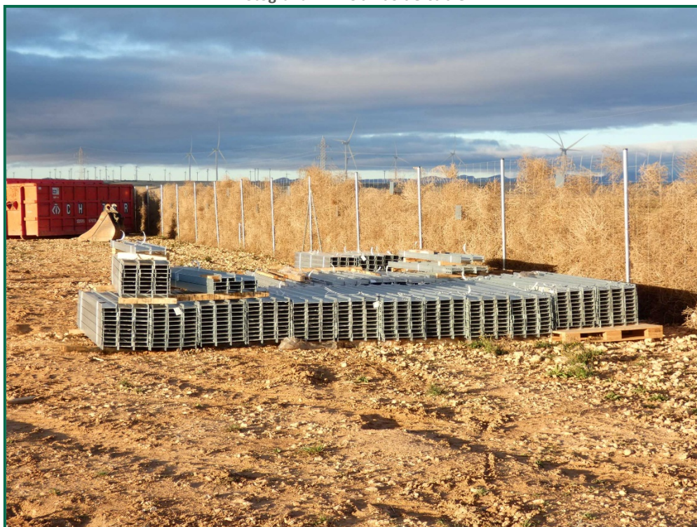
Fotografía 15. Materiales de obra.
