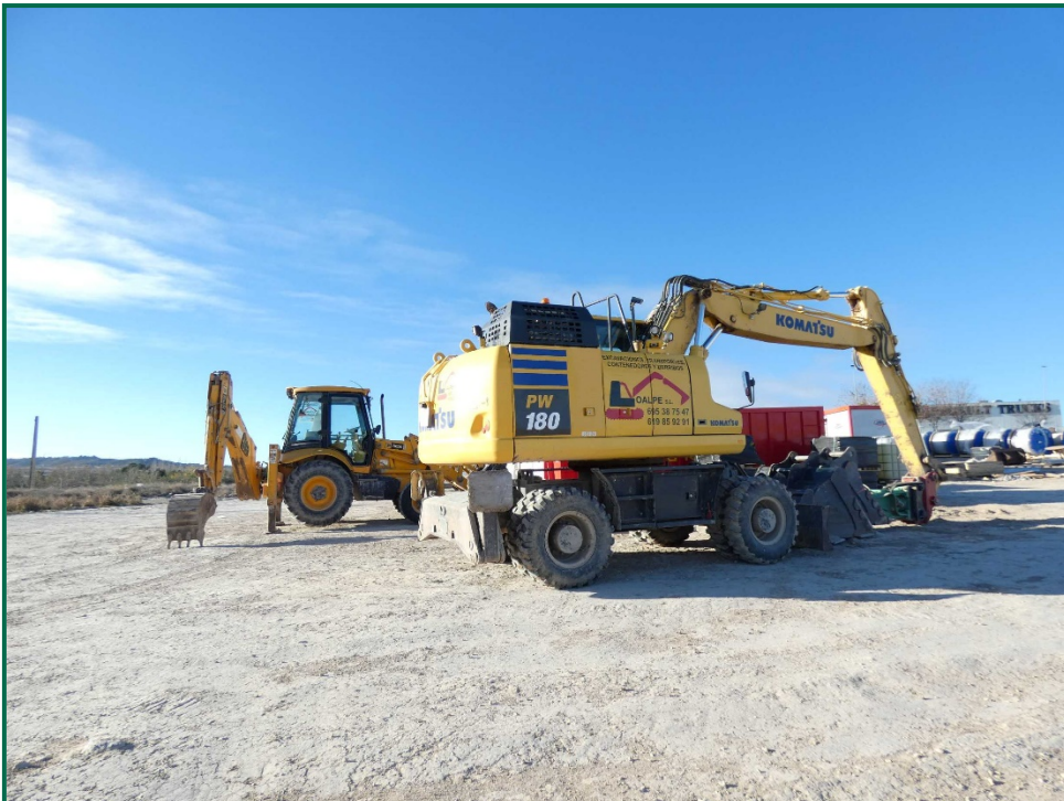
Fotografía 2. Maquinaria de construcción.
