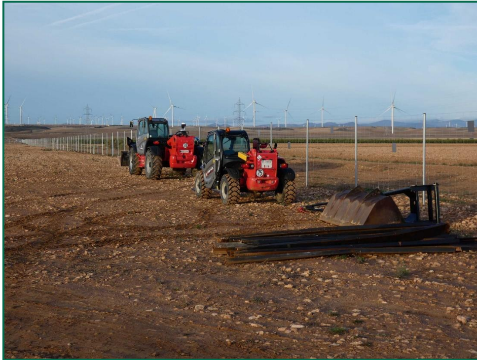
Fotografía 1. Maquinaria de construcción.
