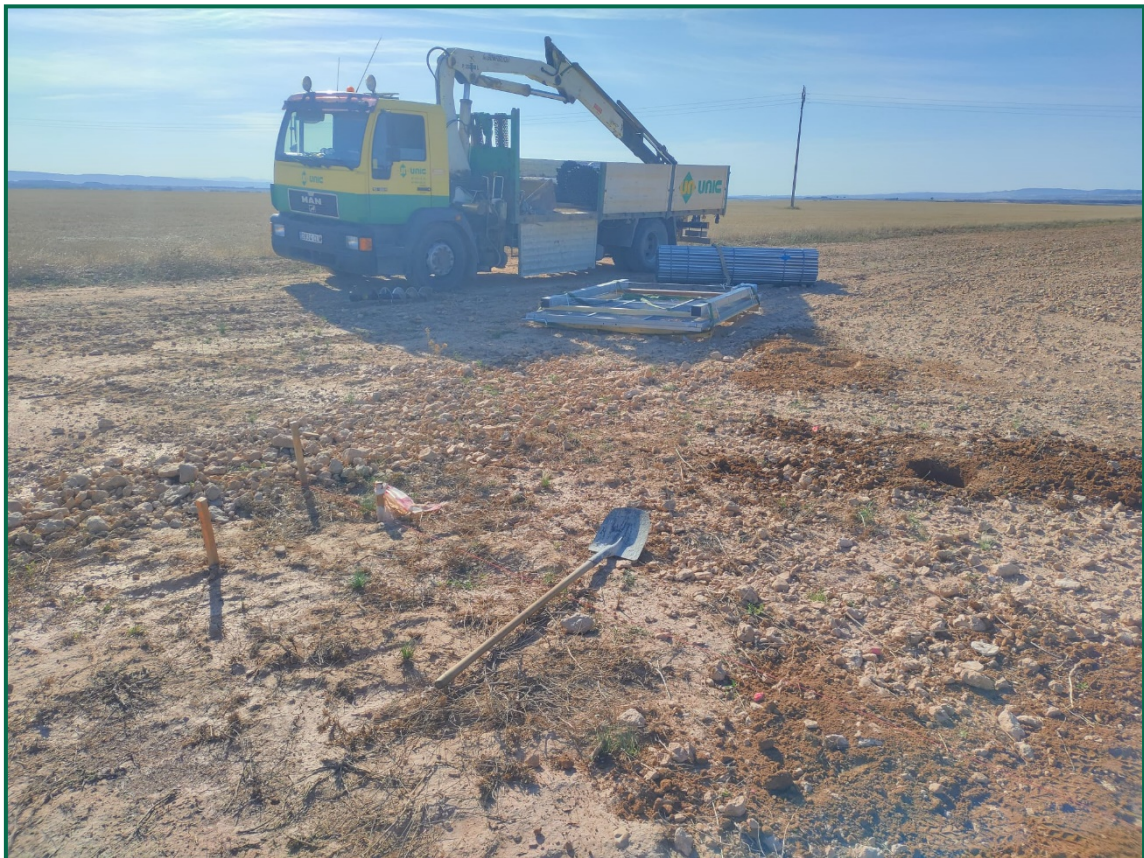
Fotografía 1. Jalonamiento y realización de hoyos.
