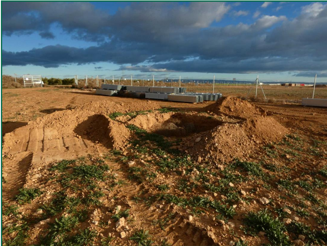
Fotografía 12. Balsa de limpieza.
