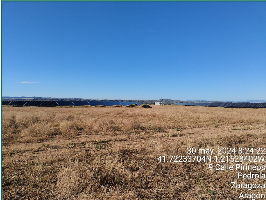
Fotografía 1. Superficie de la obra.
