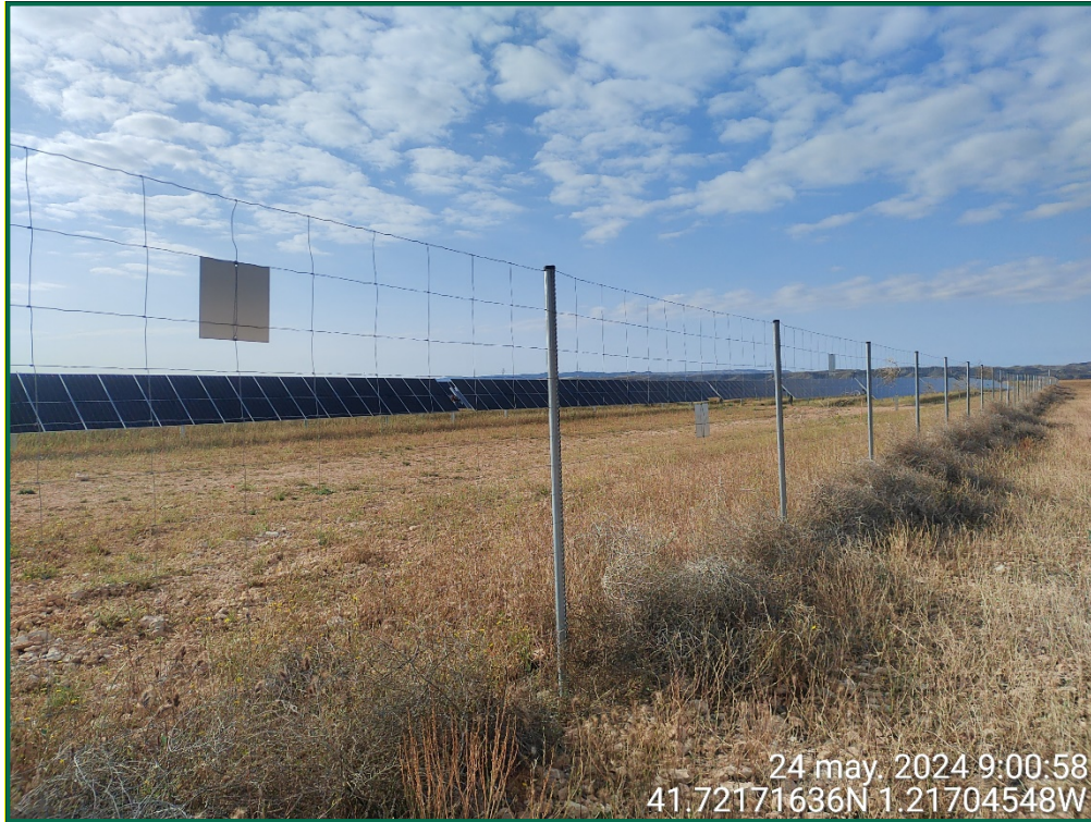
Fotografía 10. Vallado perimetral y placas anticollisión.
