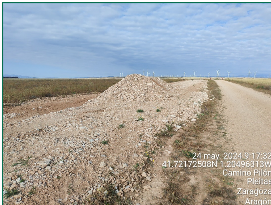
Fotografía 14. Acopios de tierra.
