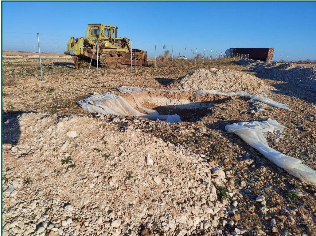
Fotografía 15. Balsa de limpieza.
