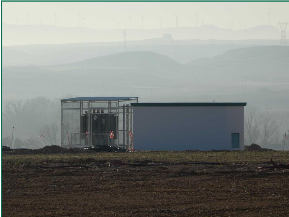
Fotografía 6. Colocación de inversores.
