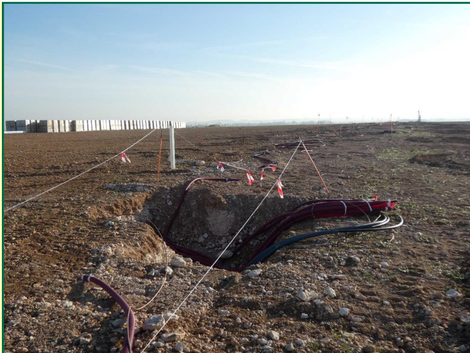
Fotografía 1. Jalonamiento de zanjas.
