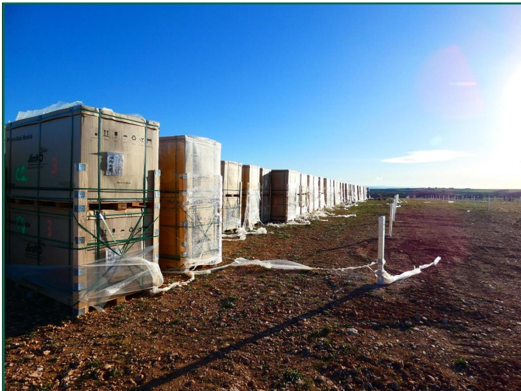
Fotografía 16. Materiales con el embalaje desprendido por la acción de fuertes vientos.
