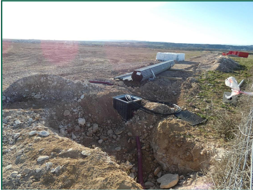
Fotografía 4. Tapado de zanjas.
