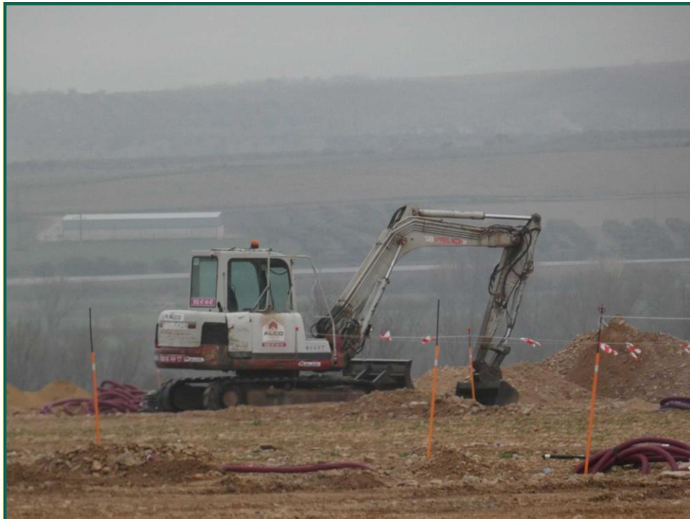
Fotografía 2. Escavadora tapando zanjas.
