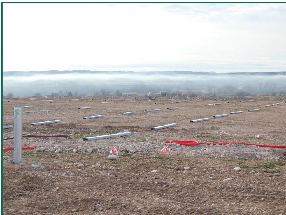
Fotografía 7. Colocación de postes verticales.
