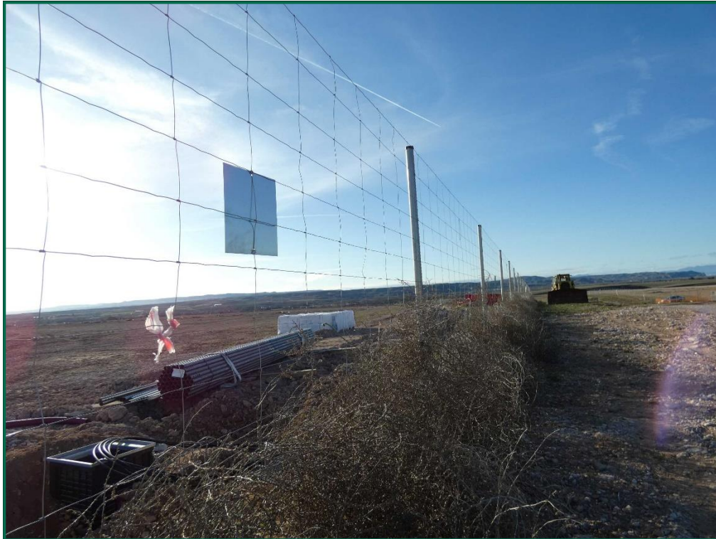
Fotografía 10. Vallado perimetral y placa anticollisión.
