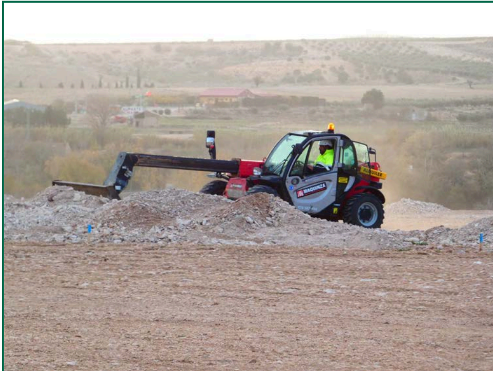
Fotografía 3. Maquinaria transportando material.
