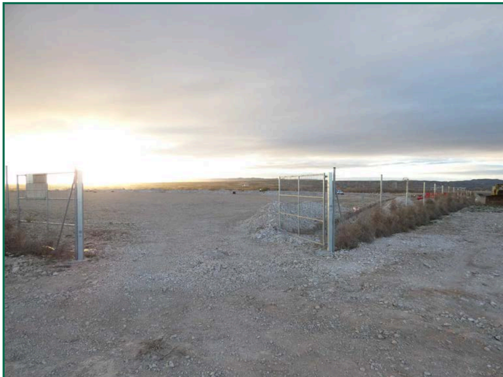
Fotografía 6. Superficie y entrada a la obra.
