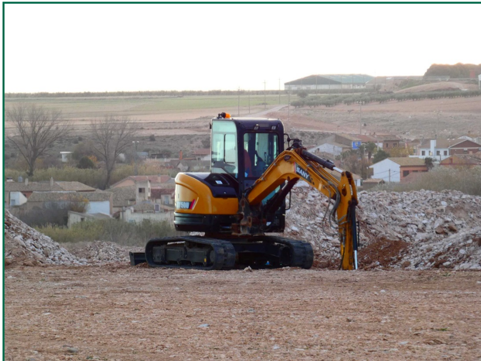
Fotografía 2. Escavadora realizando zanjas.
