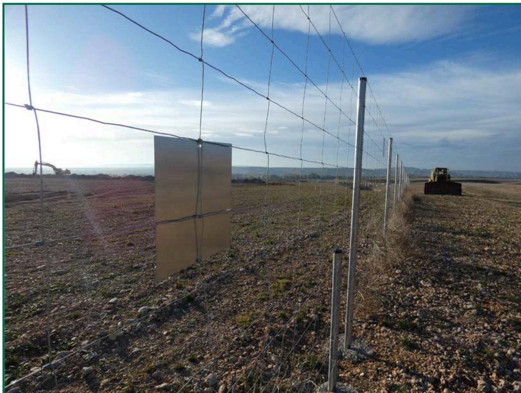
Fotografía 7. Vallado perimetral y placa anticolidión.
