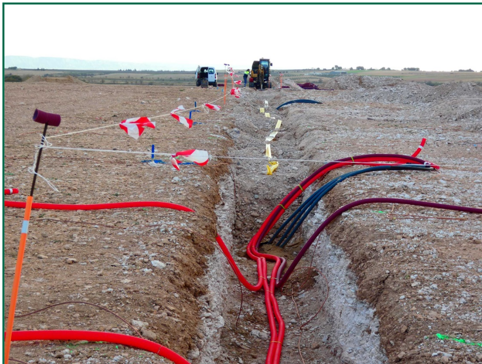
Fotografía 5. Zanjas y colocación del cableado.
