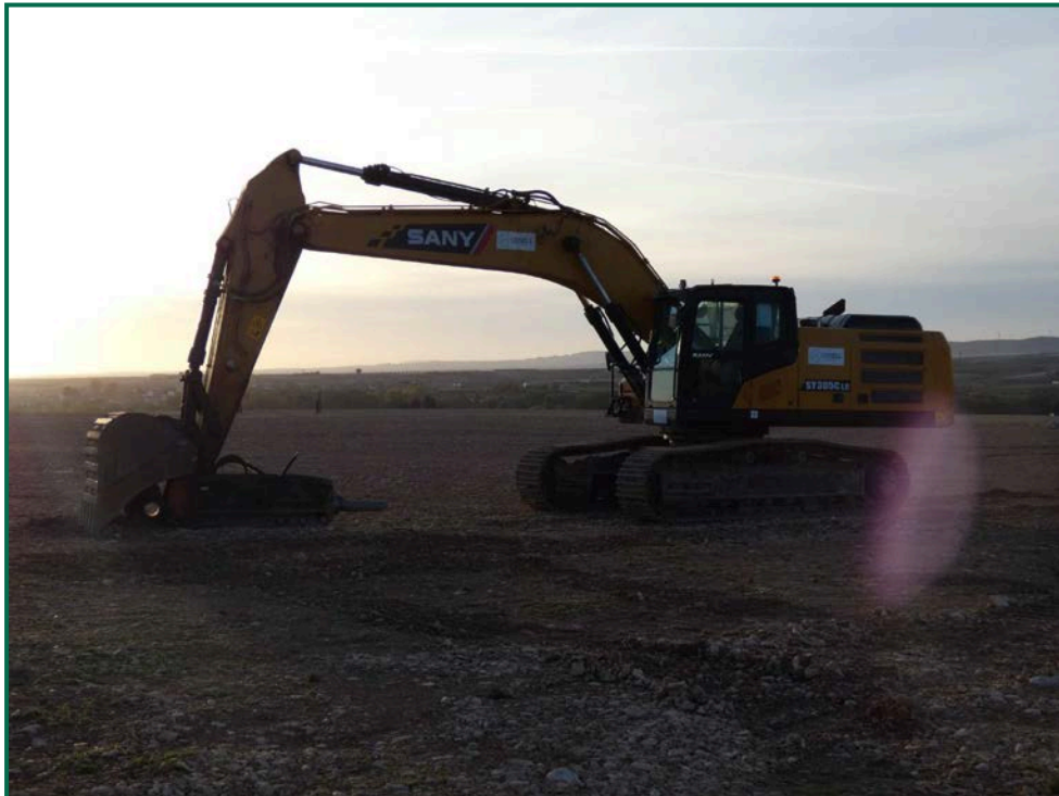
Fotografía 2. Maquinaria de construcción.
