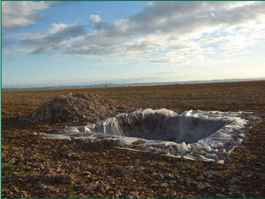
Fotografía 12. Balsa de limpieza.
